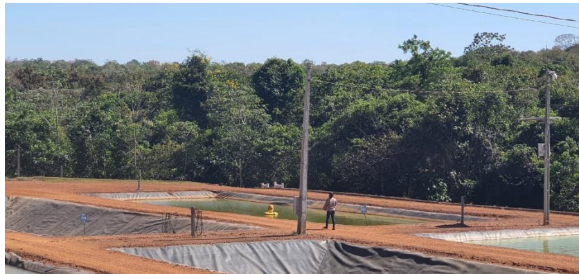
Figura 2 — Viveiros escavados revestidos com geomembrana
