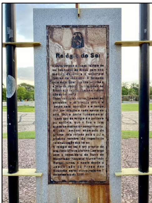
Figura 36 – Placa no monumento 'Relógio do Sol', enferrujada e ilegível.
