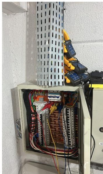
Figura 3 - Instalação do Analisador de Energia no local de estudo.
