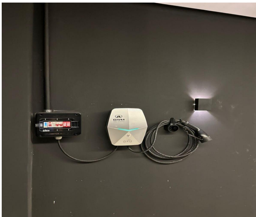
Figura 18 - Exemplo de Instalação do Carregador Portátil
