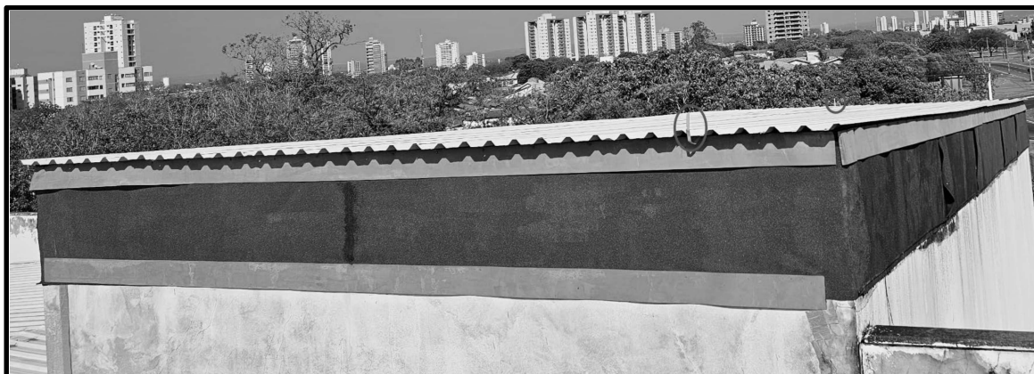
Figura 16 - Registro fotográfico do telhado com laje impermeabilizada
