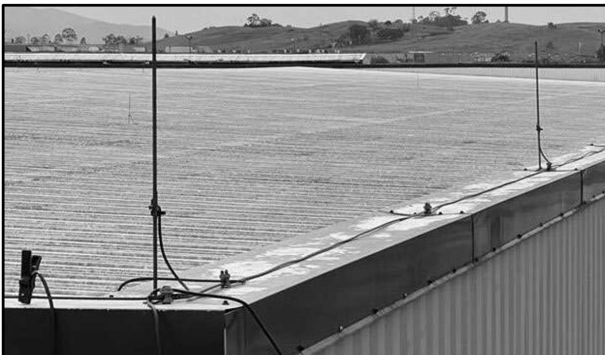
Figura 2 - Instalação SPDA
