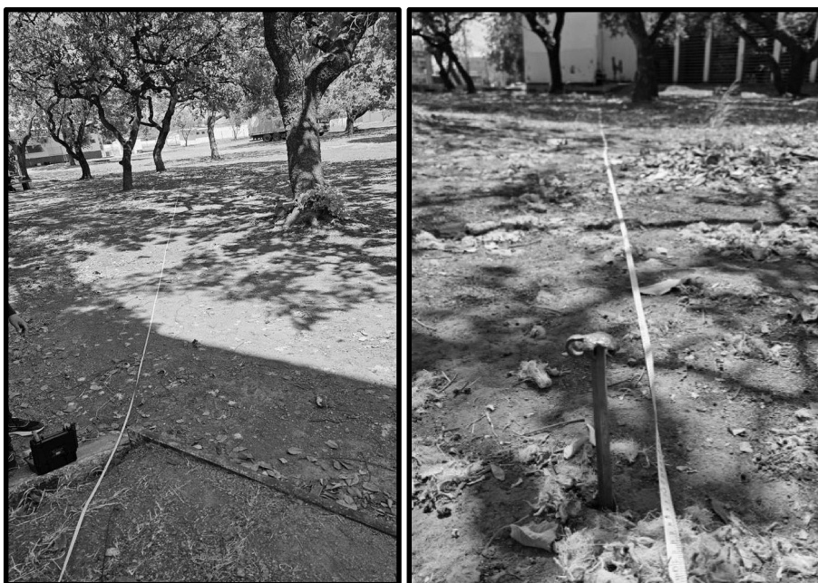
Figuras 28 e 29 - Disposição das hastes para medição da resistência de aterramento
