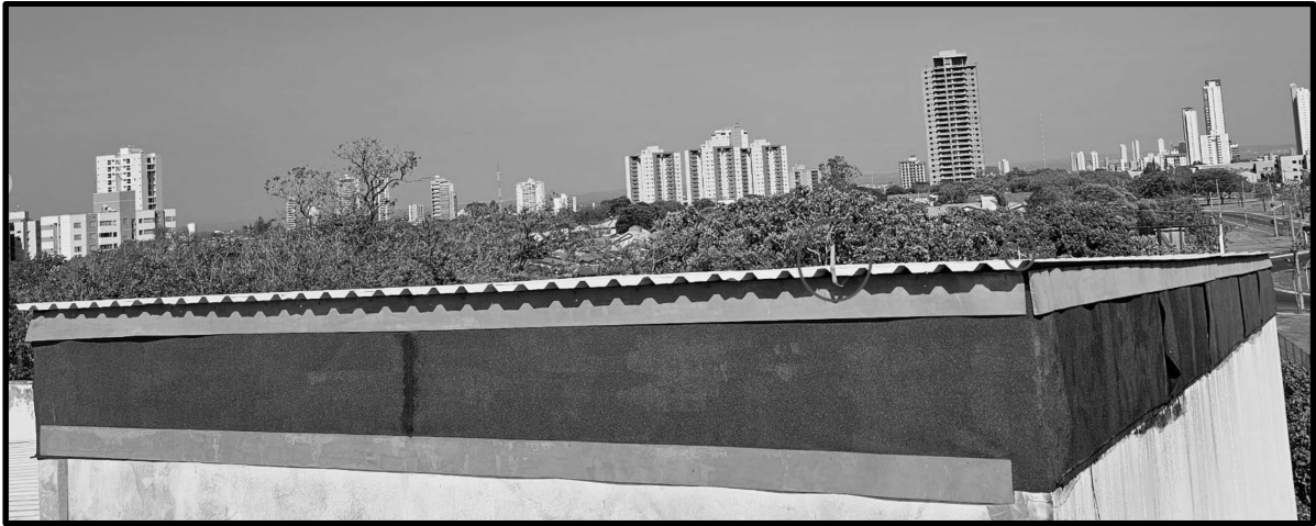
Figura 15 - Registro fotográfico do telhado com laje impermeabilizada
