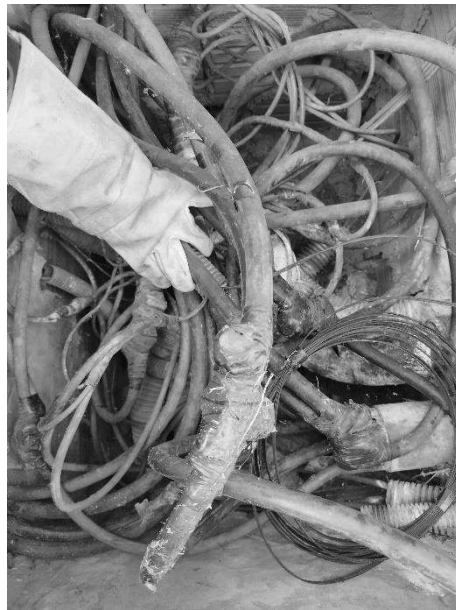
Figura 8 - Canecões com conector grampo
