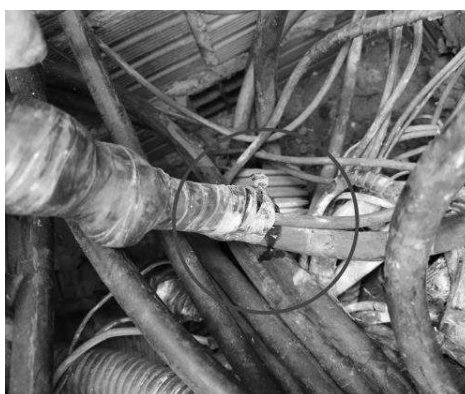
Figura 10 - Conector grampo apresentando falhas
