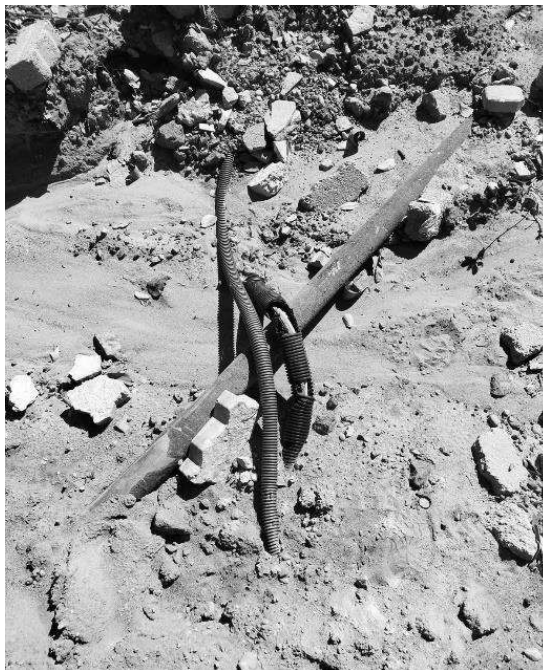
Figura 15 - Condutor exposto
