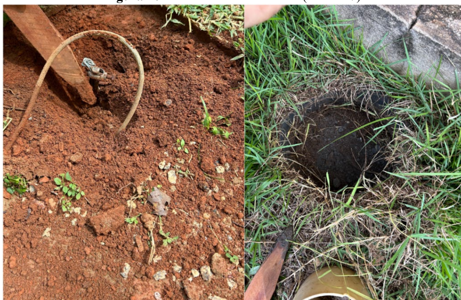
Figura 40 - Caixas de difícil acesso (Bloco 17).
