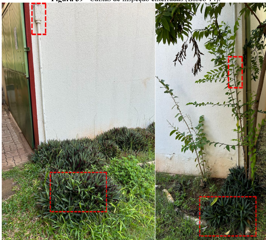
Figura 39 - Caixas de inspeção enterradas (Bloco 14).
