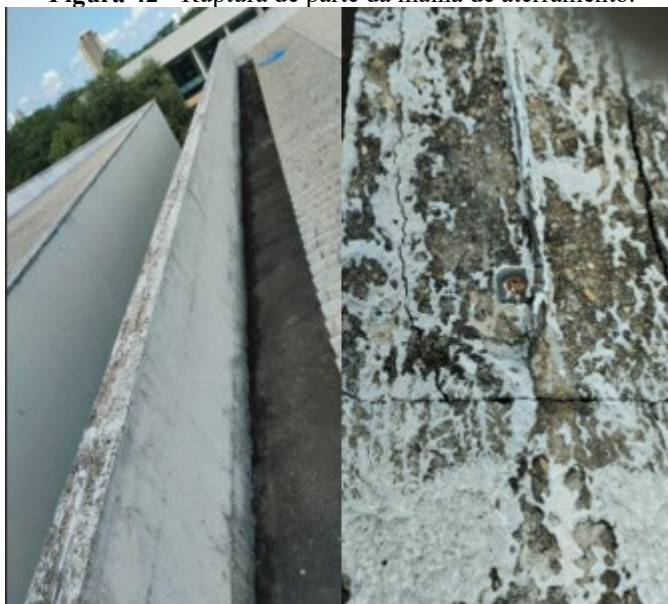
Figura 42 - Ruptura de parte da malha de aterramento.
