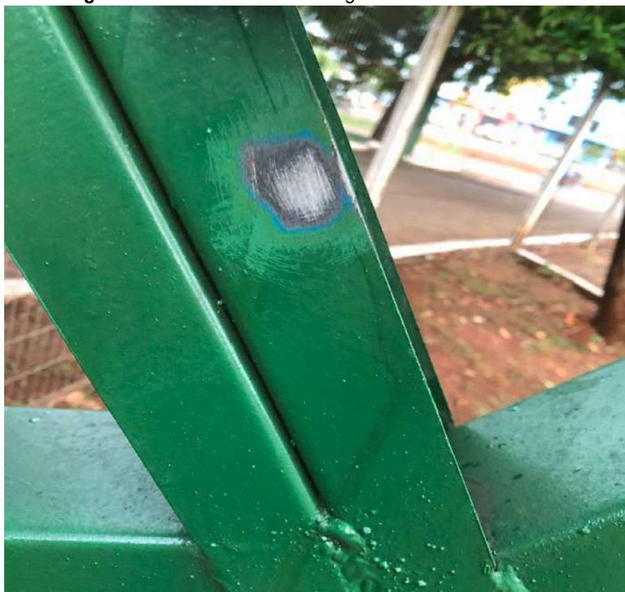
Figura 30 - Parte da estrutura na guarita de entrada do IFTO
