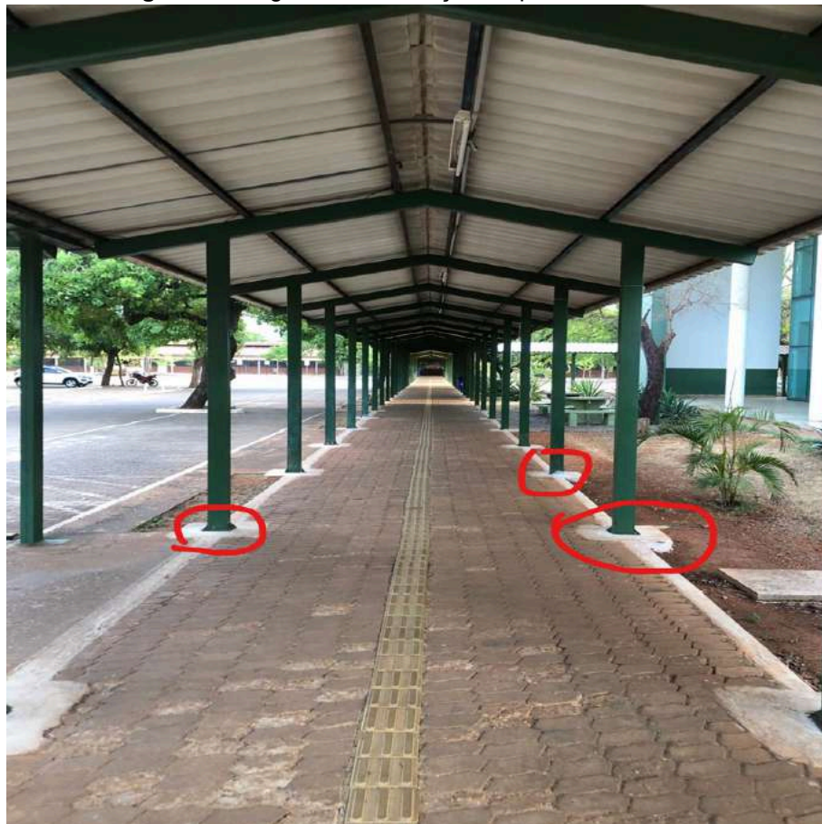
Figura 23 - Vigas de sustentação da passarela coberta.
