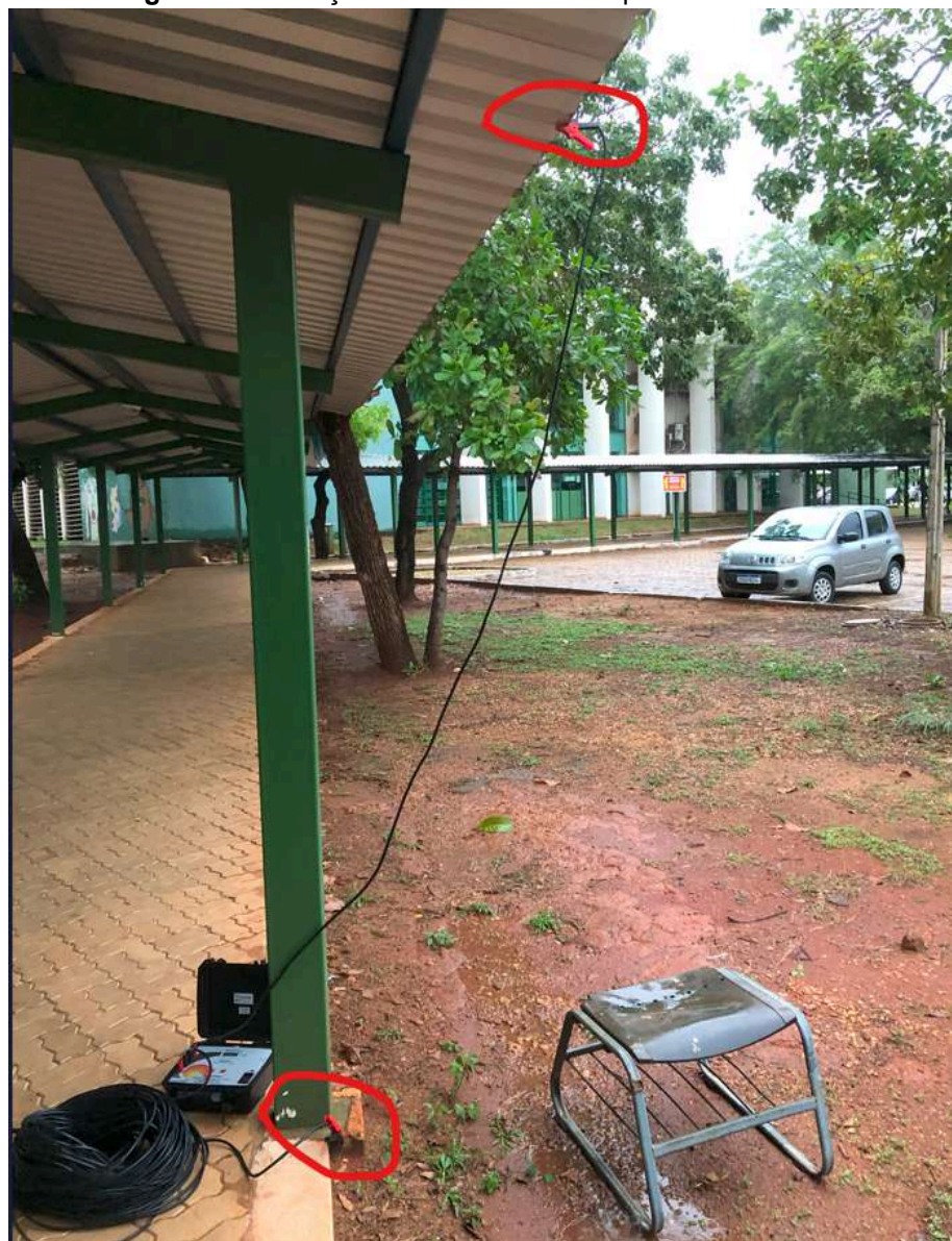
Figura 28 - Medição da continuidade da passarela coberta.
