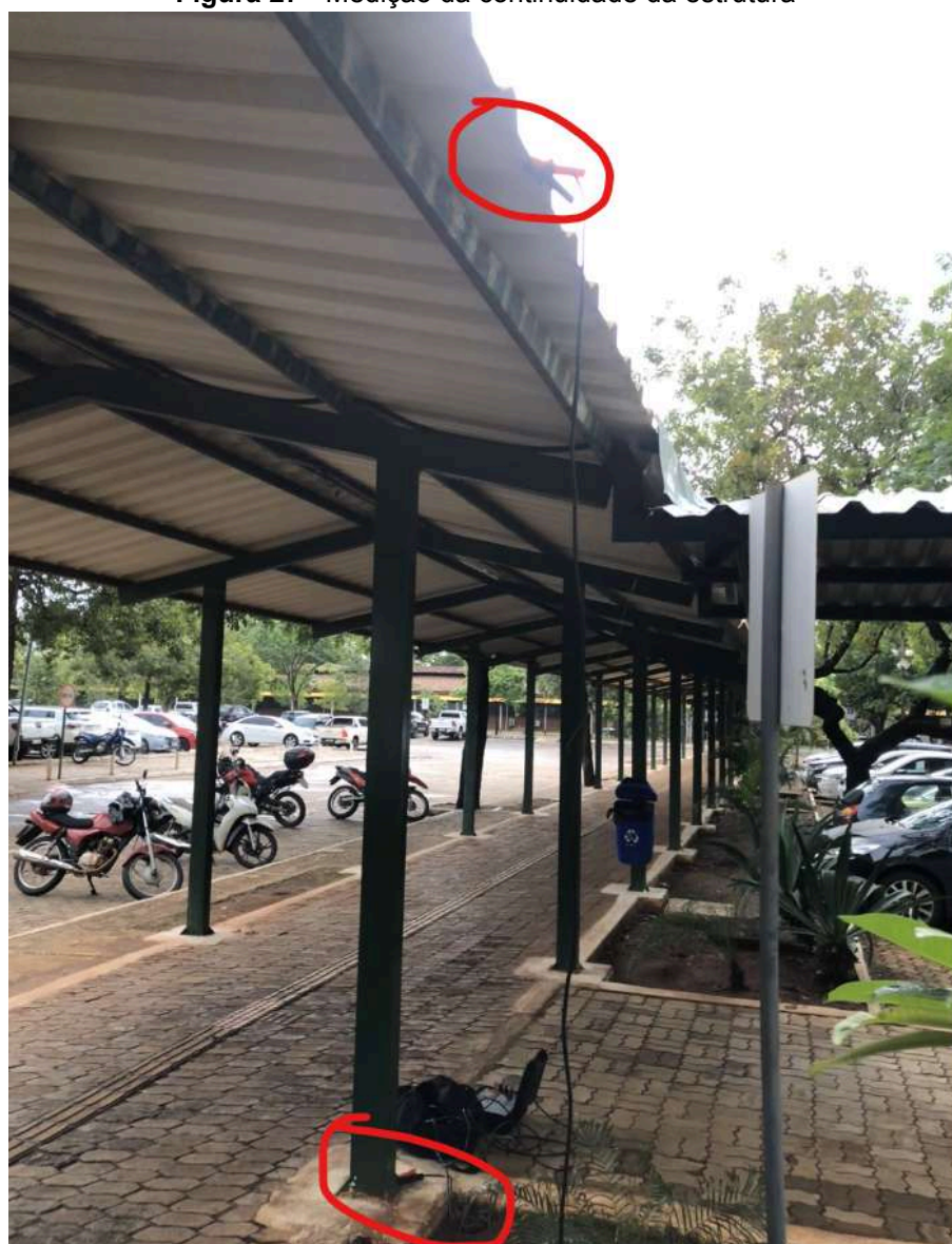
Figura 27 - Medição da continuidade da estrutura
