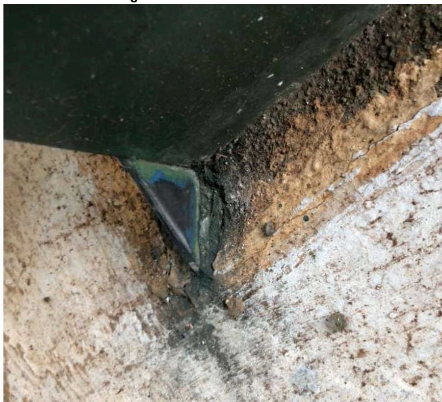
Figura 31 - Base da coluna metálica
