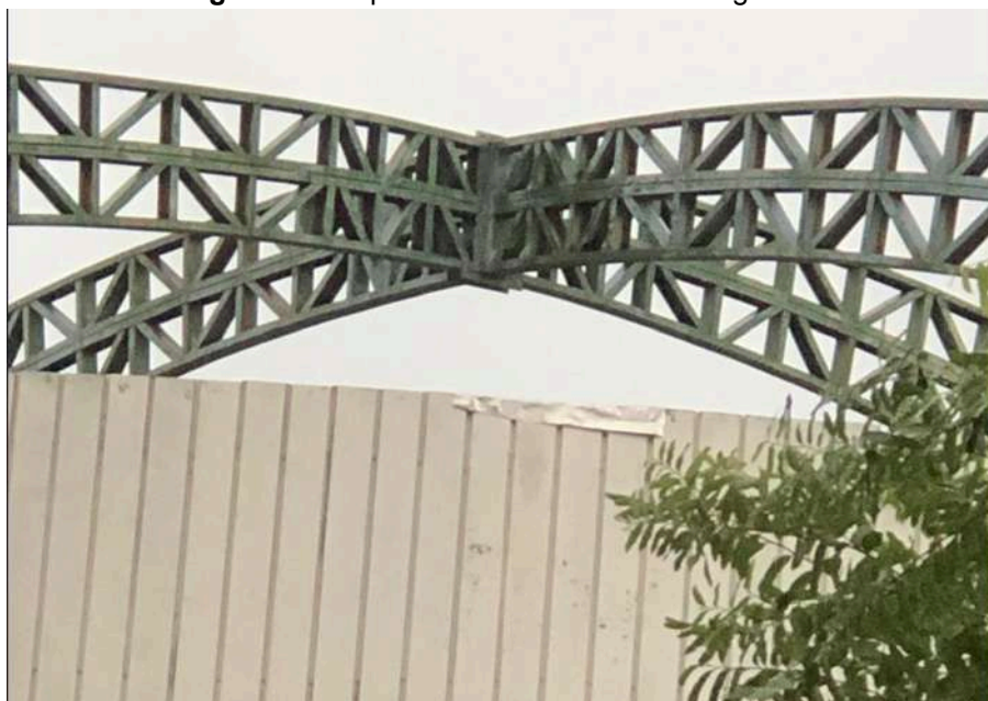
Figura 33 - Topo da estrutura metálica da guarita
