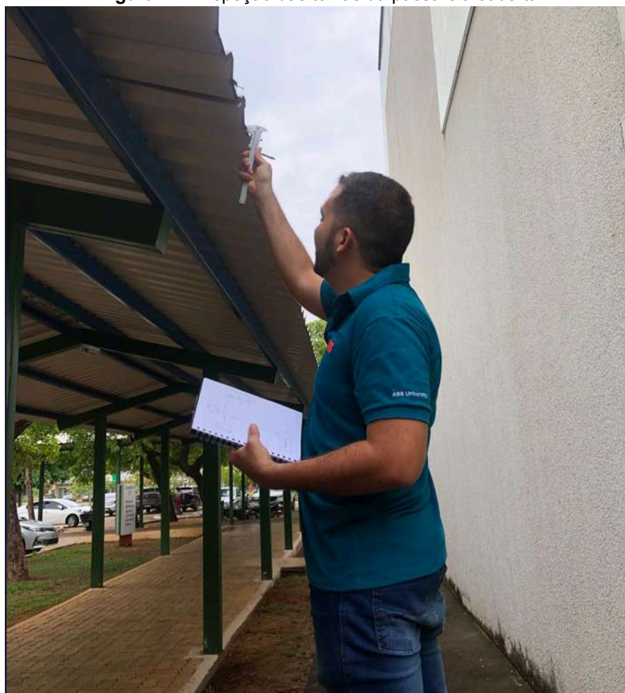
Figura 21 - Inspeção das telhas da passarela coberta
