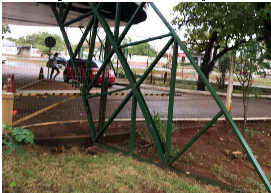
Figura 34 - Base da estrutura metálica da guarita
