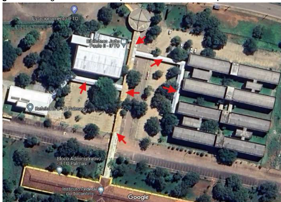
Figura 2 - Imagem de satélite da passarela coberta do Campus Palmas do IFTO
