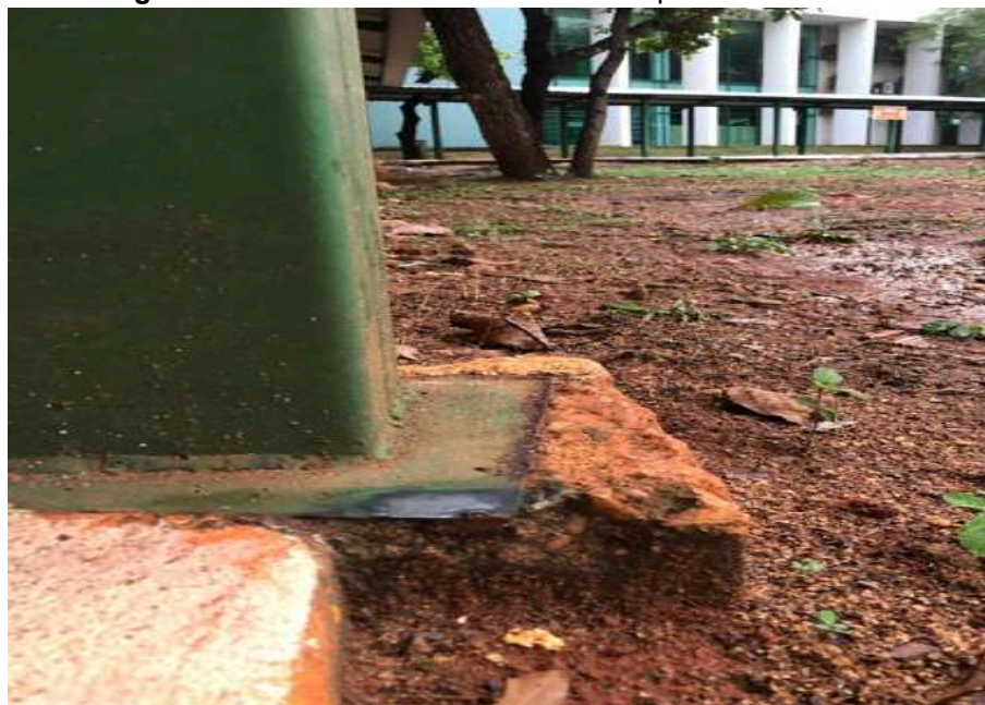
Figura 41 - Base metálica da estrutura da passarela coberta.
