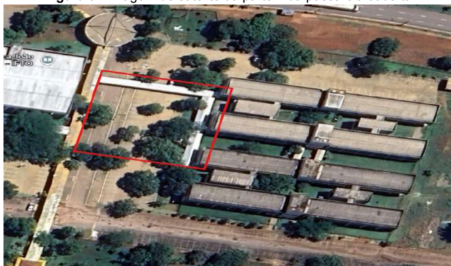
Figura 9 - Imagem de satélite da parte 2 da passarela coberta.
