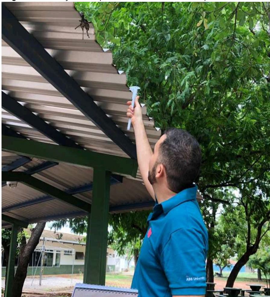
Figura 38 - Medição da espessura da telha utilizada na passarela coberta.
