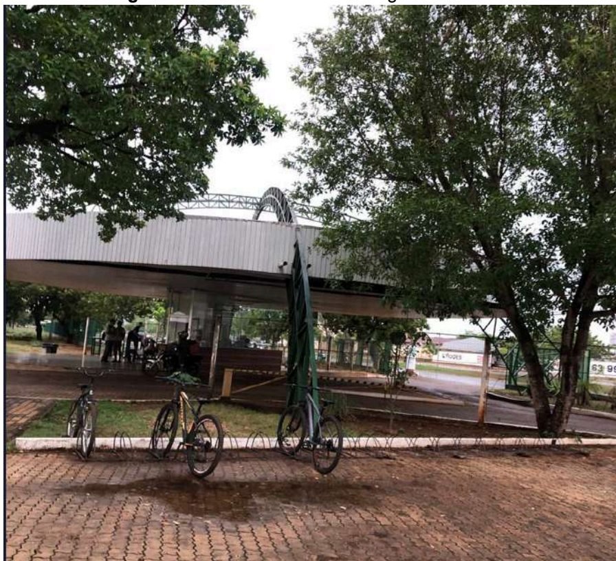
Figura 32 - Estrutura metálica da guarita do IFTO
