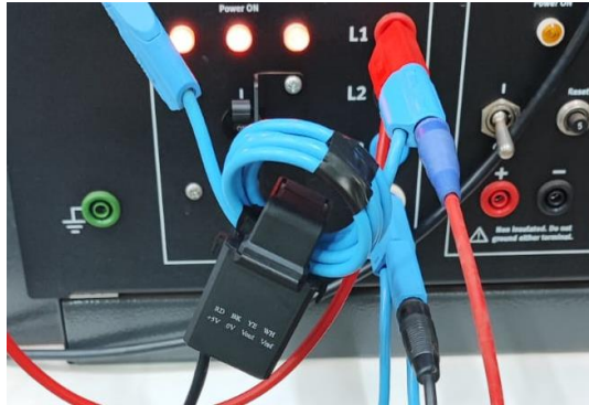
Figura 21 - Condutor com 6 espiras na entrada do sensor de corrente
