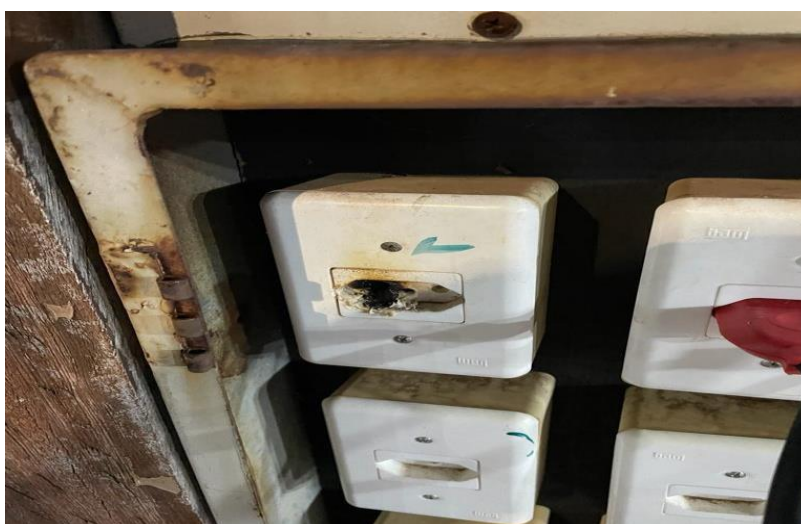
Figura 16 - Tomada comprometida.
