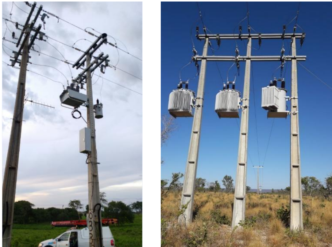
Figura 11 - Religador e Regulador de tensão
