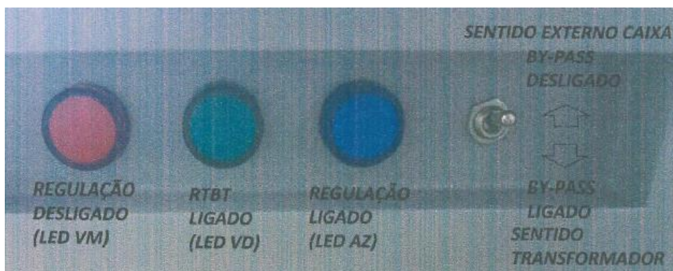
Figura 6 – Dispositivos visuais de identificação de funcionamento do RTBT
