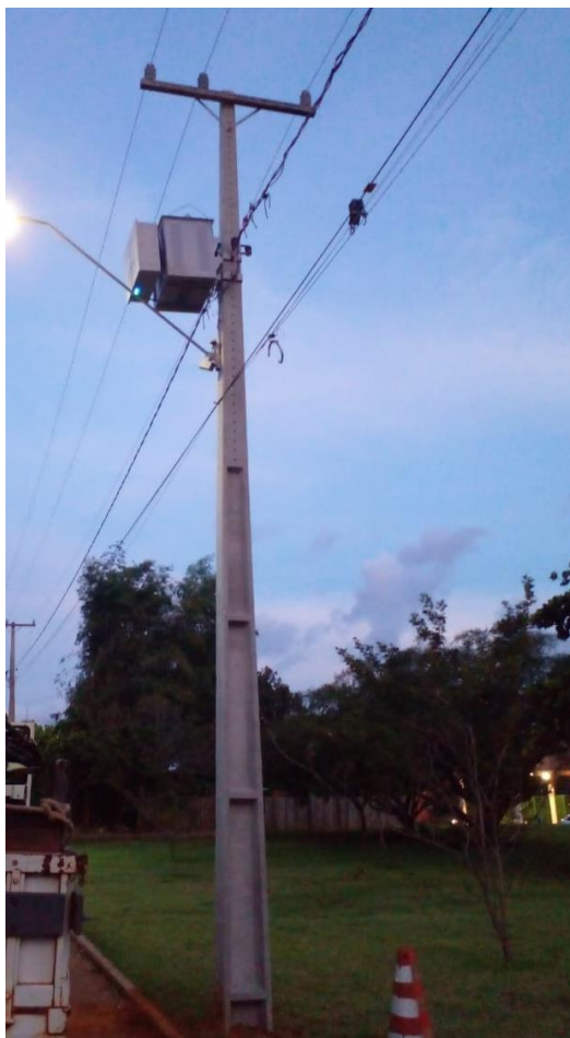
Figura 5 – RTBT em funcionamento
