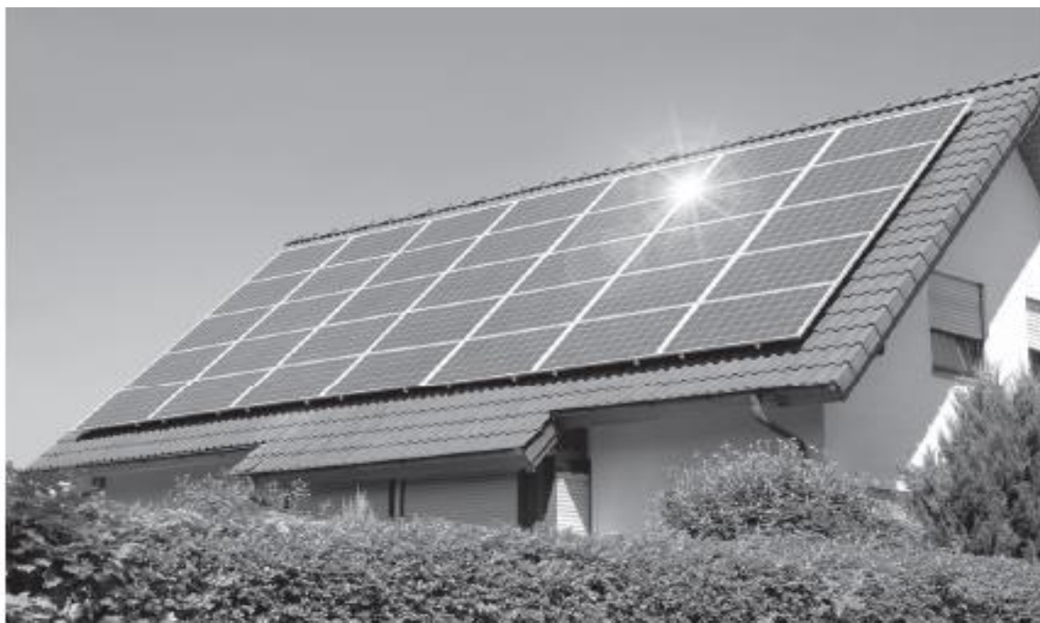
Figura 2 – Placas fotovoltaicas para geração de eletricidade
