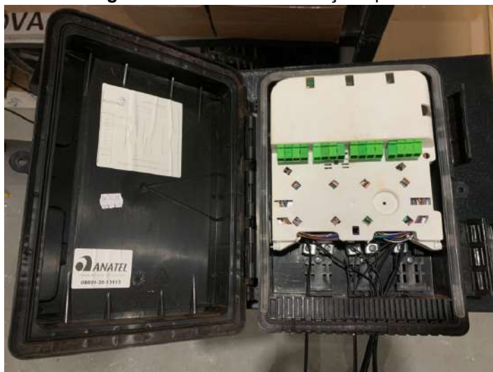
Figura 26 - Caixa de terminação óptica
