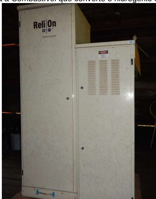
Figura 11 - Célula a Combustível que converte o hidrogênio em energia elétrica
