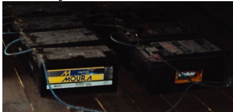
Figura 19 - Banco de baterias do CPC
