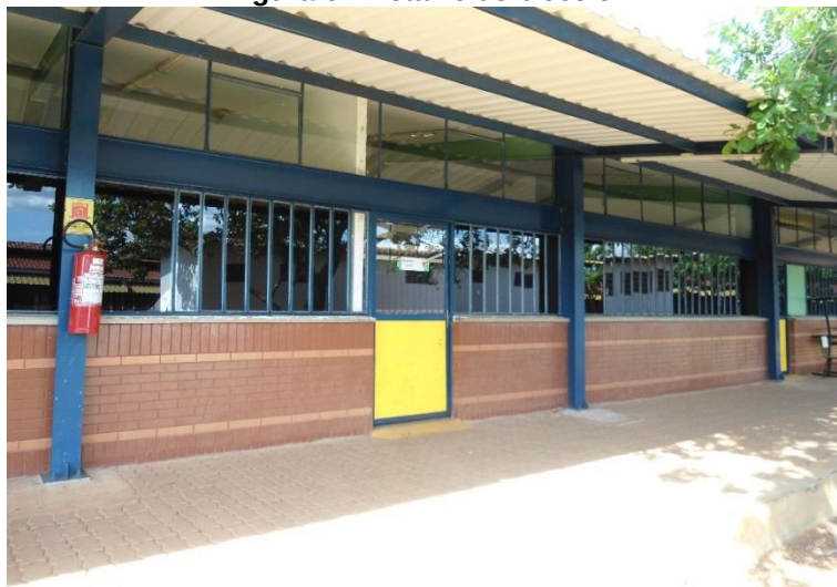
Figura 6 - Detalhe do bloco 5A
