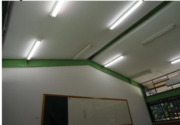
Figura 5 - Teto de sala de aula do IFTO, Campus Palmas
