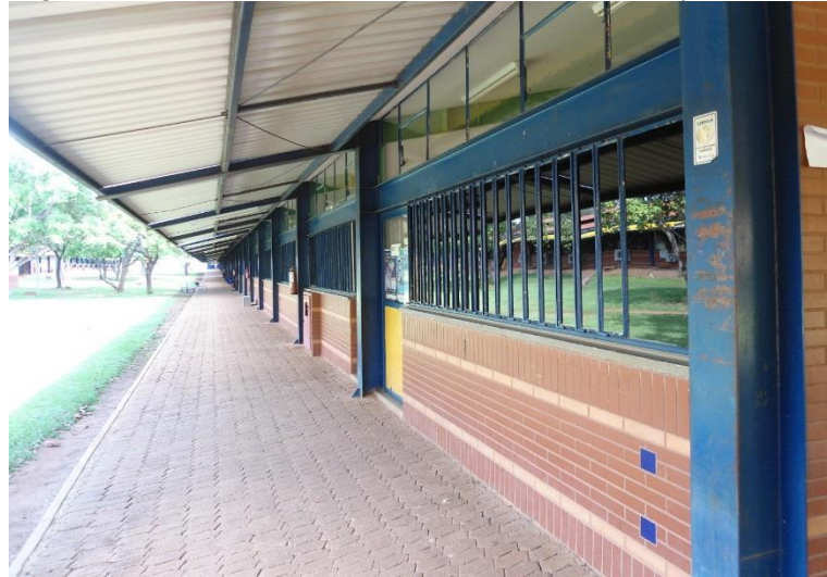
Figura 4 - Parede externa do bloco 9 do IFTO, Campus Palmas
