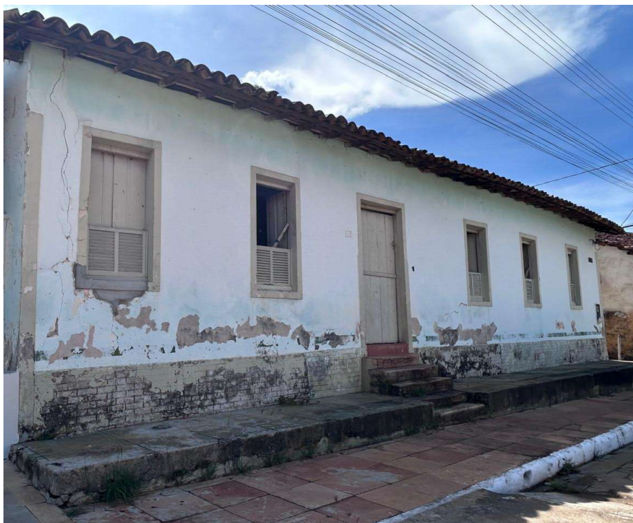
Figura 4 - Fachada frontal do Canteiro Modelo de Conservação do Tocantins.
