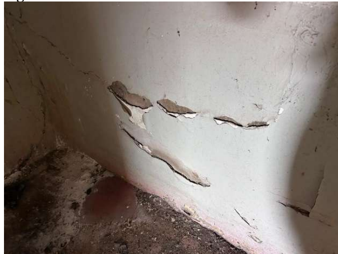
Figura 28 - Descolamento ou destacamento - Atelier.
