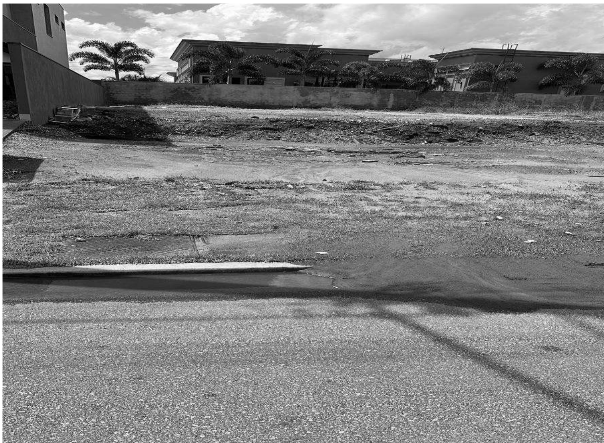
Figura 3: Escoamento de água pluvial causado pela pouca taxa de vegetação.
