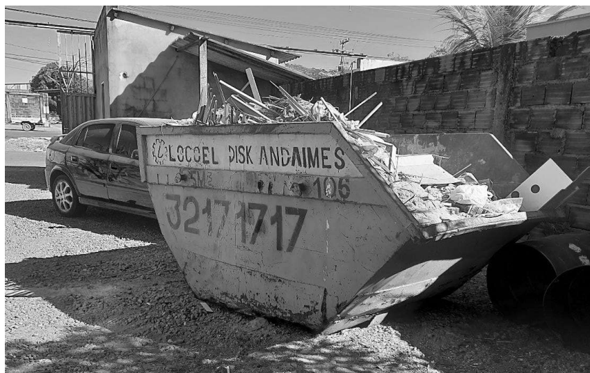
Figura 12 - Container destinado ao armazenamento de resíduos.
