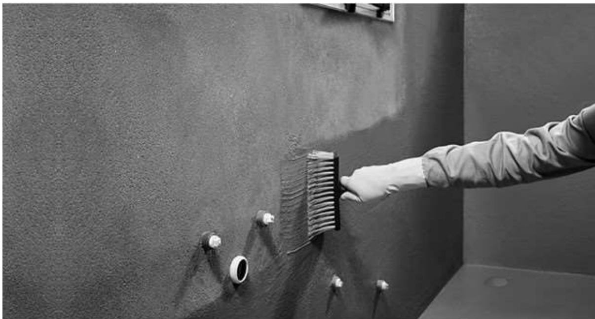
Figura 03 - Aplicação Argamassa Polimérica
