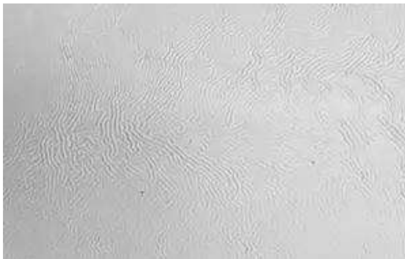
Figura 12 – Patologia na pintura: Enrugamento.
