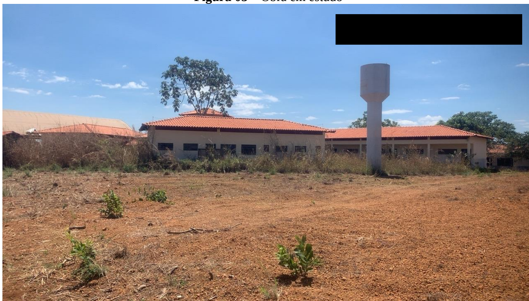
Figura 03 – Obra em estudo
