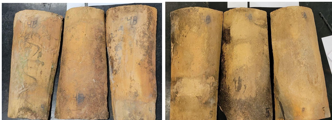
Fotografia 18 e Fotografia 19 - Ensaio de inspeção visual imóveis 4(a) e 5(b)
