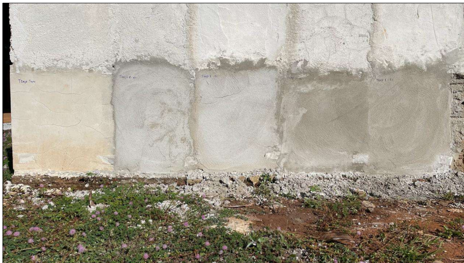
Figura 11. Reboco em parede.
