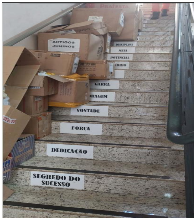
Figura 35 - Saída de emergência obstruída
