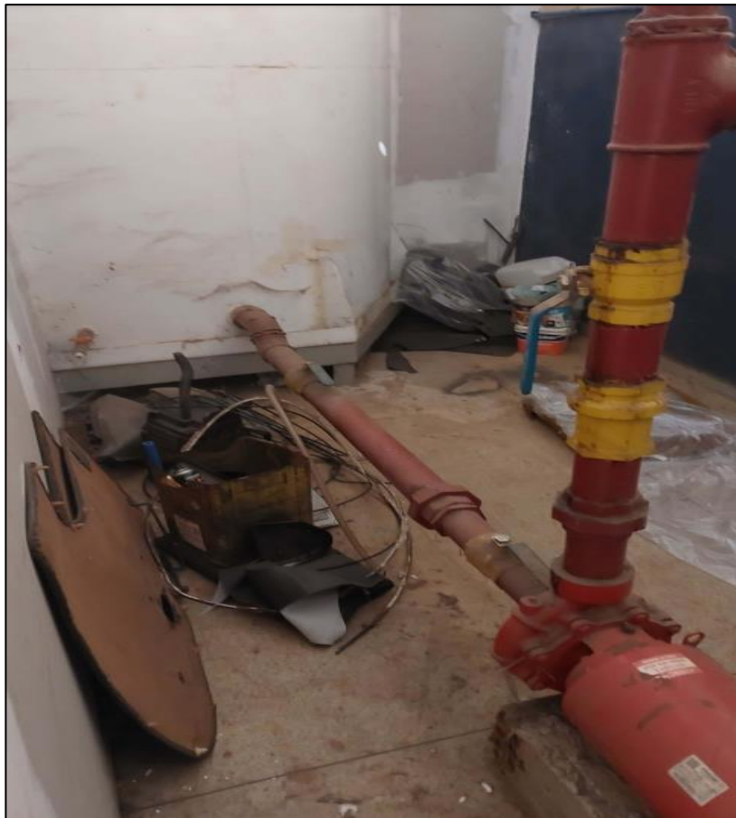
Figura 33 - Casa de bomba sendo utilizada com depósito
