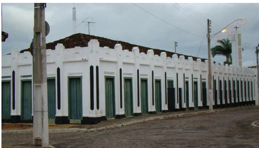
Figura 2 - Construção em adobe em Calculé na Bahia
