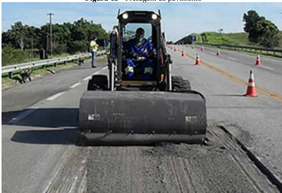
Figura 13 - Fresagem de pavimento
