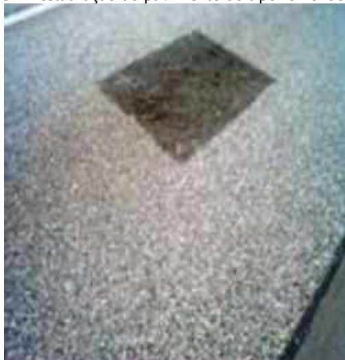
Figura 9 - Restauração do pavimento do tipo remendo
