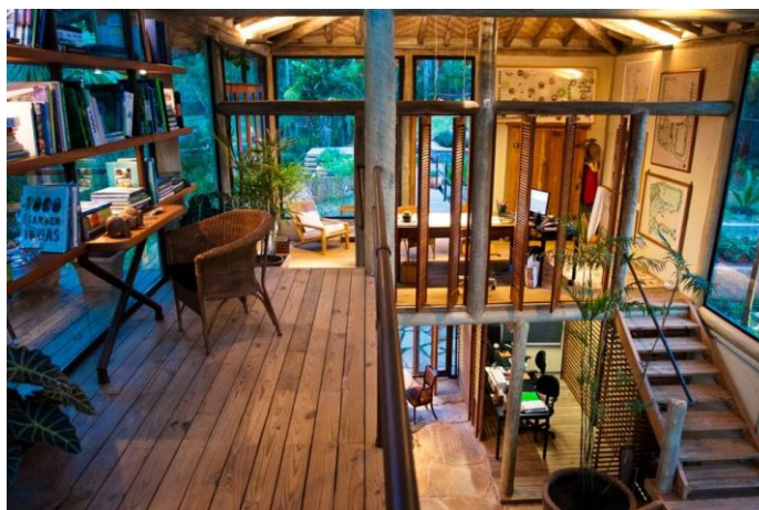
Figura 2: Mezanino com estrutura de eucalipto.
