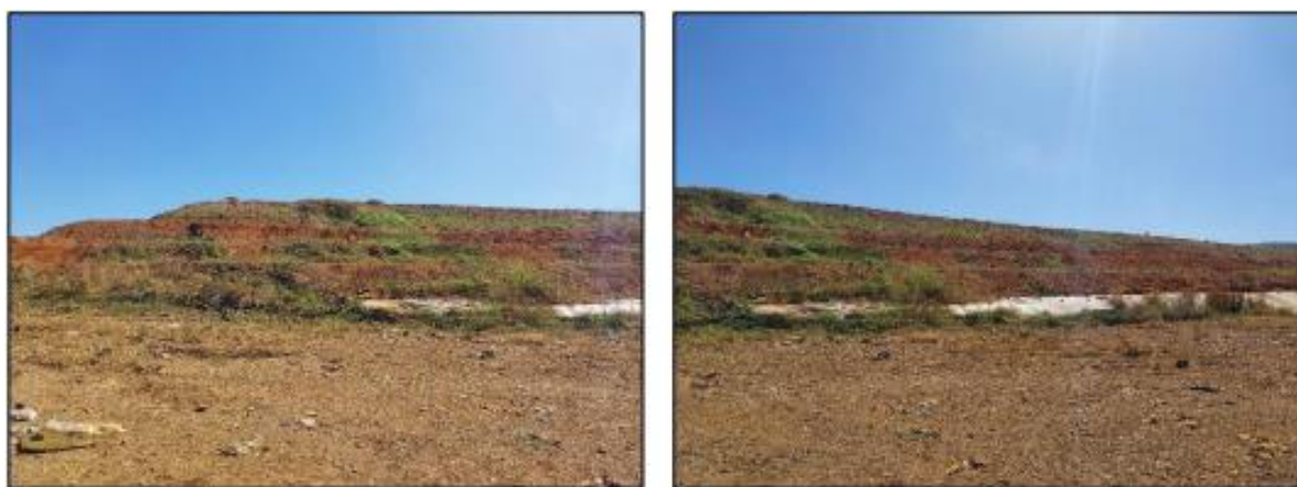
Figura 10 – Células finalizadas do Aterro Sanitário Municipal de Palmas
