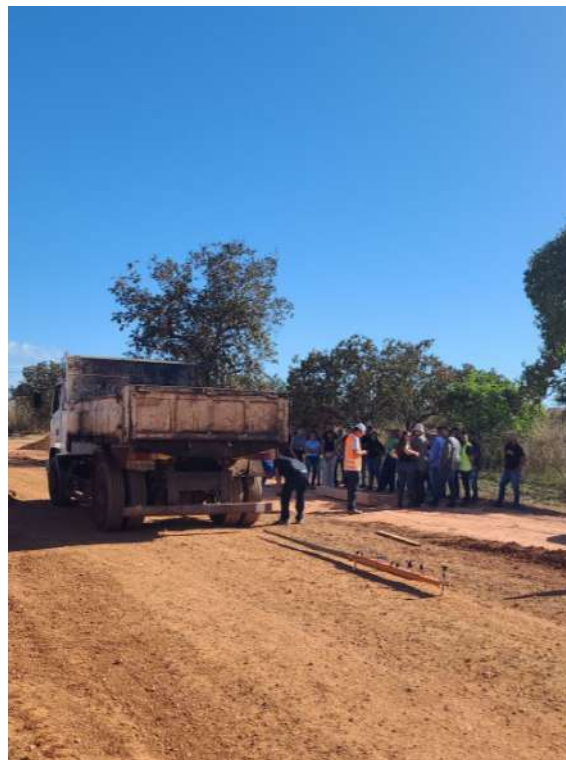
Figura 15 – Aula prática Ensaio de Viga Benkelman
