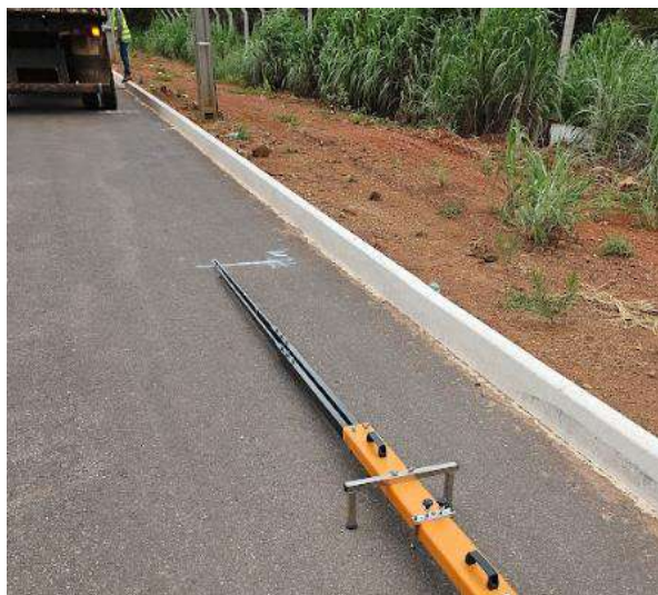
Figura 11 – Deslocamento do caminhão
