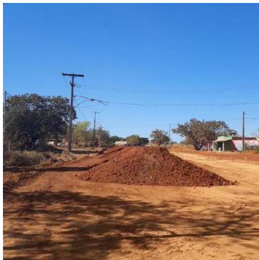
Figura 3 – Solo de base ainda não estabilizado
