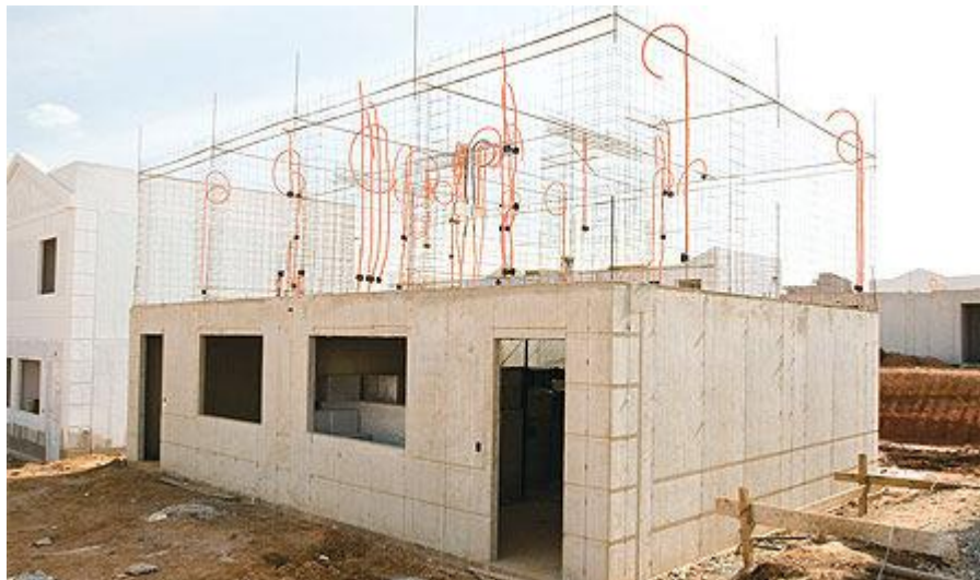
Figura 6 – Exemplificação do processo de parede de concreto
