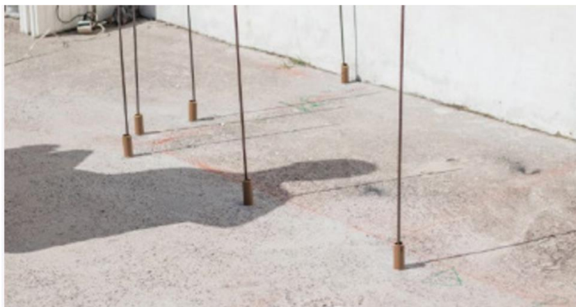
Figura 34 - Fixação barras de ferro
