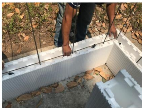
Figura 21 - Posicionamento da armadura horizontal
