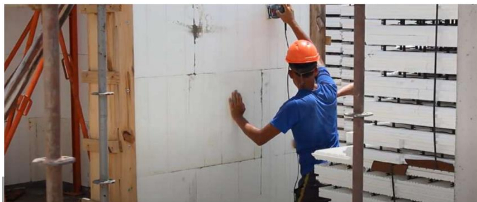
Figura 44 - Vibração com lixadeira orbital
