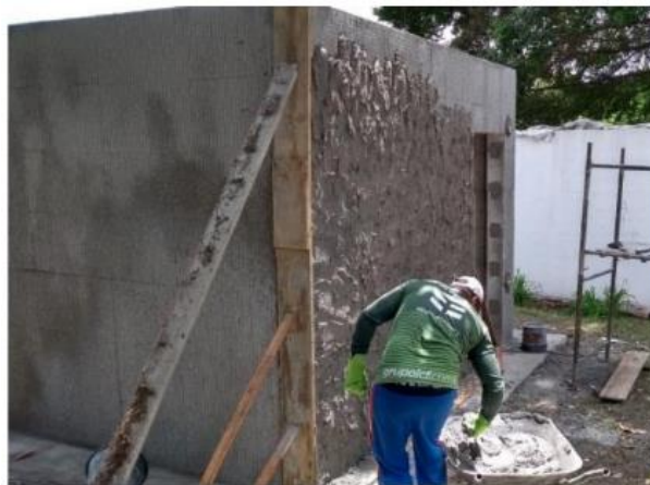
Figura 31 - Aplicação de argamassa
