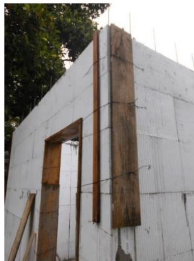
Figura 24 - Vão portas e janelas
