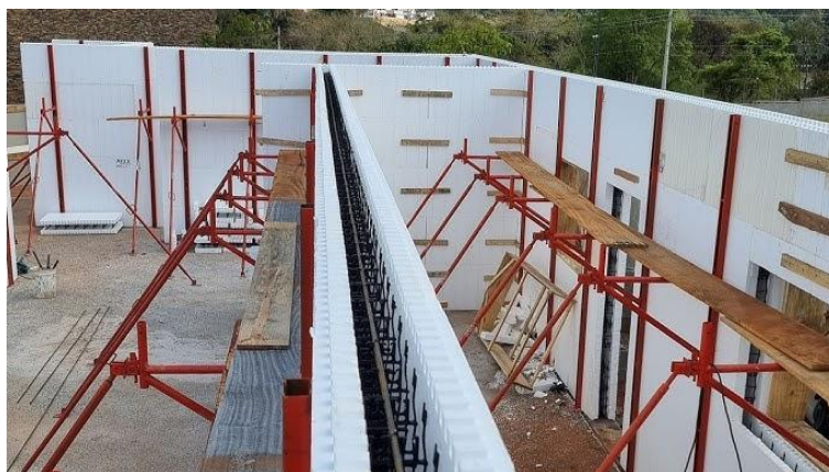
Figura 41 - Ancoragem dos blocos
