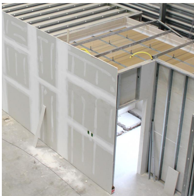
Figura 11 - Sistema em Drywall
