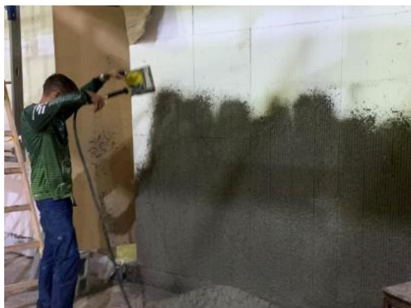
Figura 29 - Chapisco das paredes
