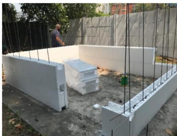
Figura 22 - Assentamento segunda fiada
