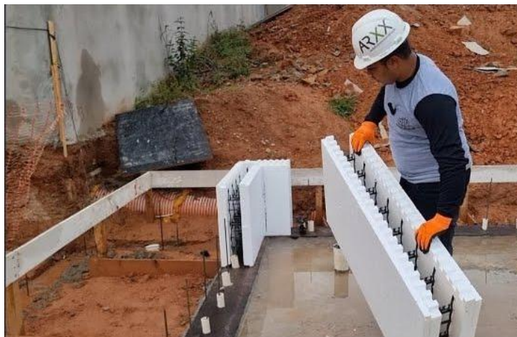
Figura 36 - Assentamento primeira fiada
