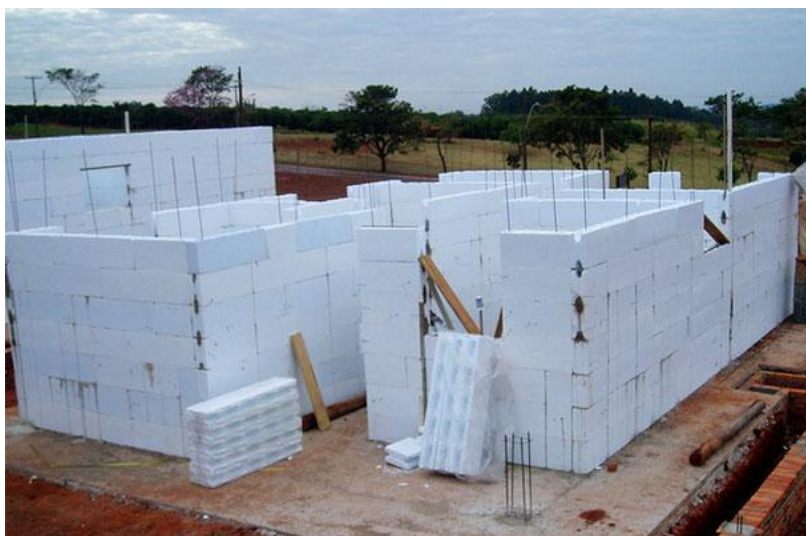
Figura 14 - Exemplificação do processo de construção do ICF
