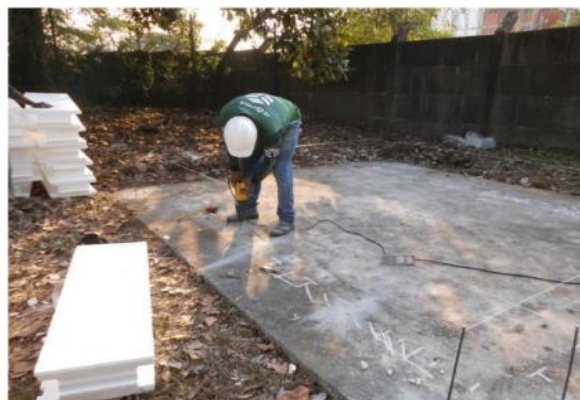
Figura 19 - Chumbamento das armaduras
