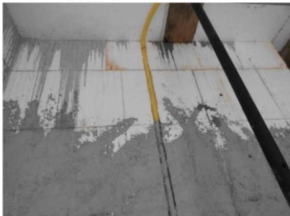
Figura 28 - Embutimento das instalações
