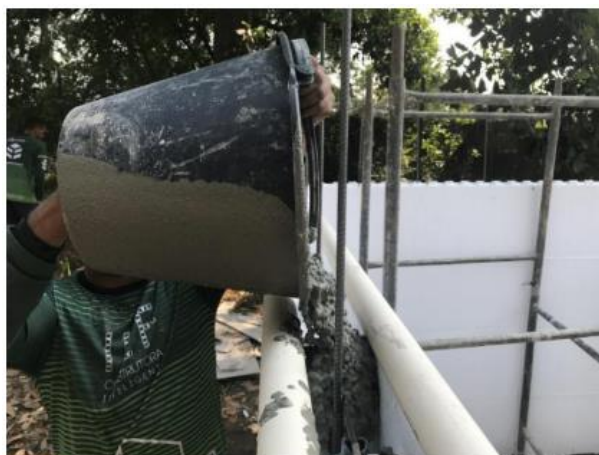
Figura 25 - Lançamento do concreto
