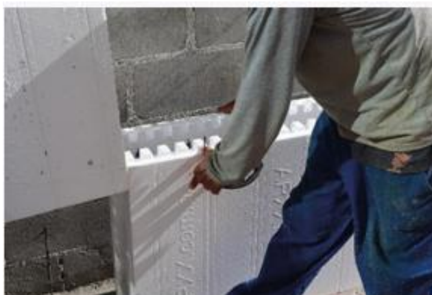
Figura 35 - Assentamento primeiro bloco
