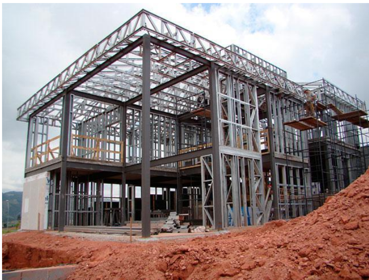
Figura 10 - Casa Micura Steel Frame
