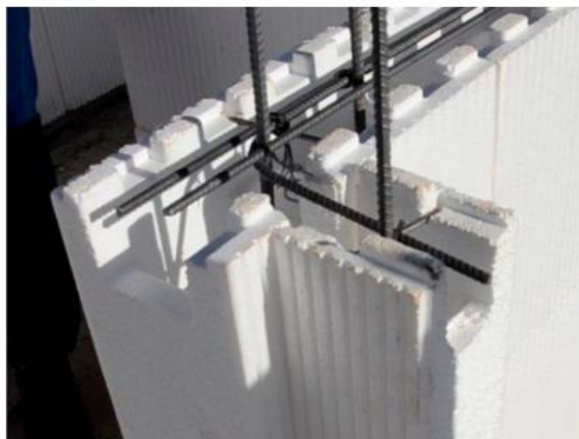
Figura 20 - Ligação entre paredes a 90 graus
