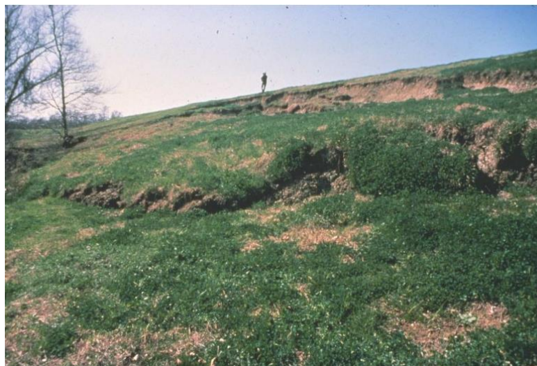
Figura 27 – Rompimento de talude decorrente de saturação.
