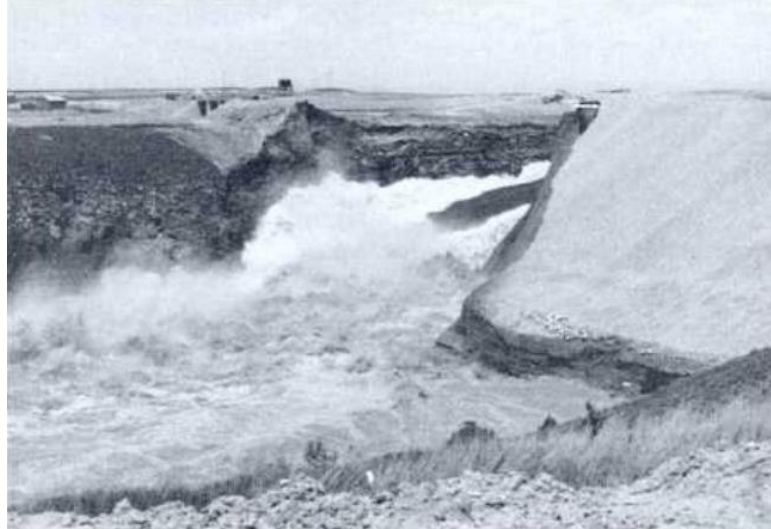
Figura 19 – Topo da barragem de Teton durante o rompimento.
