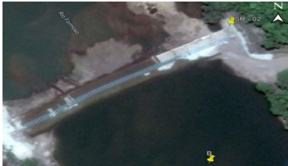
Figura 52 – Localização do furo SR – 02 na barragem B.
