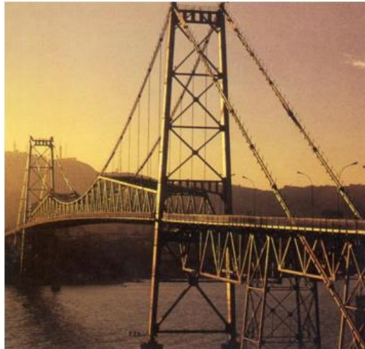
Figura 3 - Ponte em estrutura metálica – Hercílio Luz
