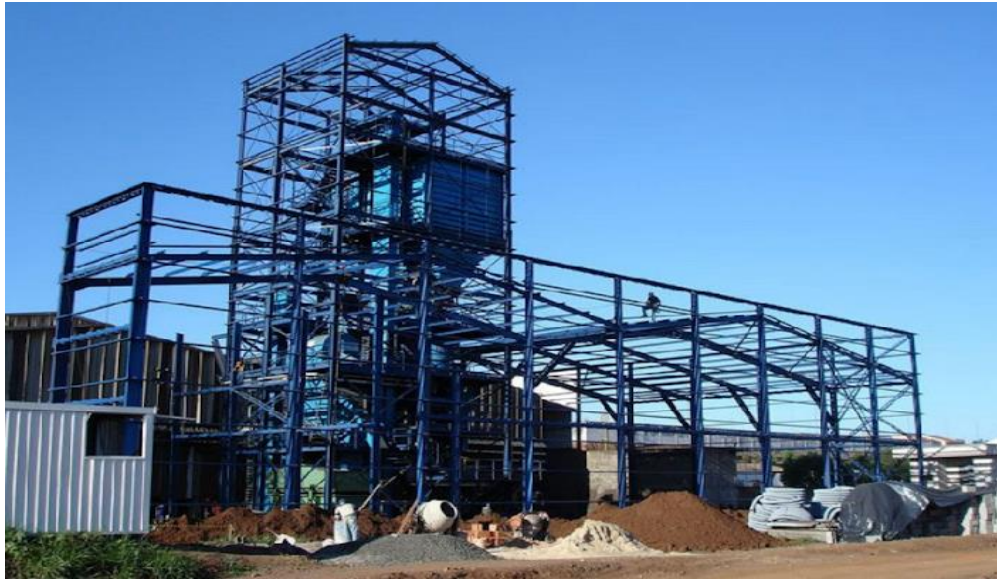
Figura 6 - Estrutura em aço
