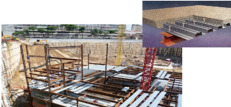
Figura 7 - Estrutura mista com laje mista
