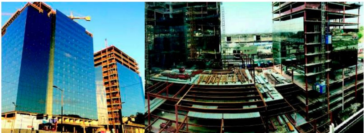
Figura 2 - Edifício de múltiplos andares – Porto Atlântico Leste
