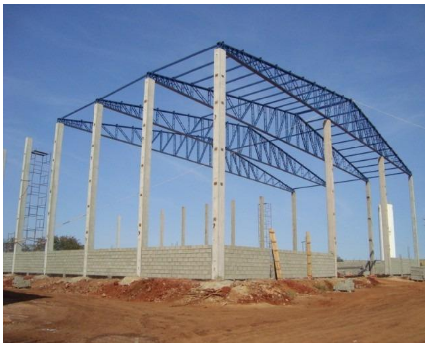
Figura 46 - Galpão com pilares em concreto
