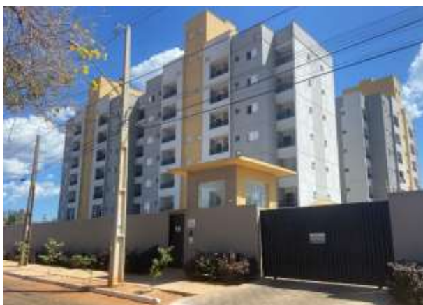
Imagem 1 – Fachada do edifício
