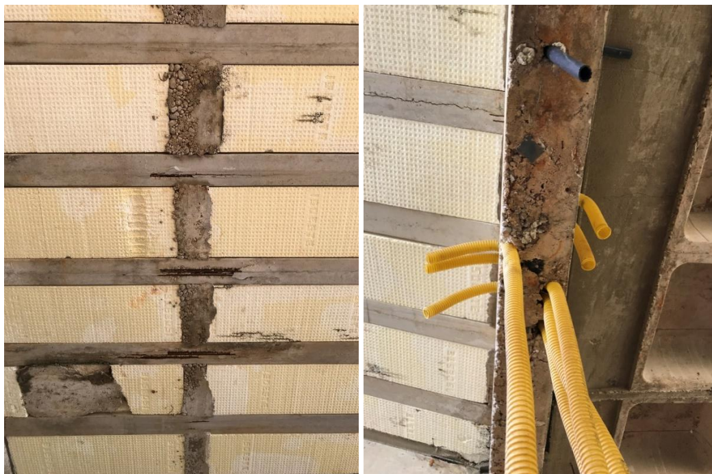
Figura 33 - Nicho de concretagem em vigas e vigotas
