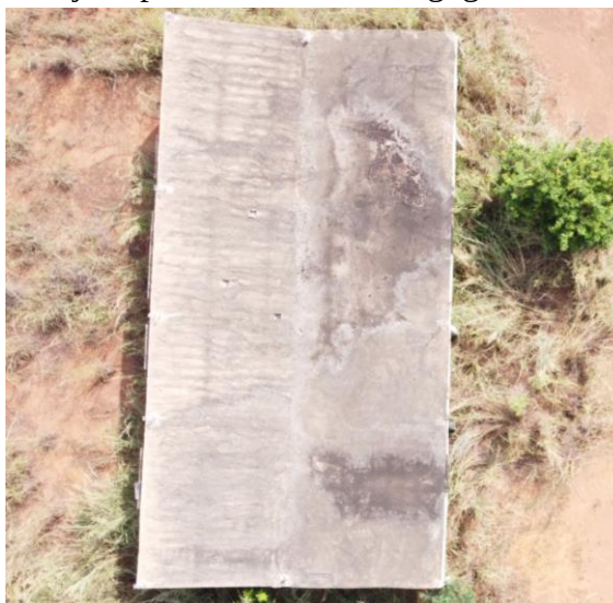
Figura 39 - Laje exposta do Bloco Pedagógico e Administrativo
