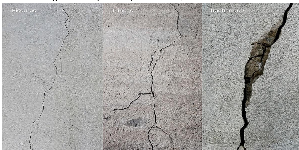
Figura 1 - Representação de fissura, trincas e rachaduras
