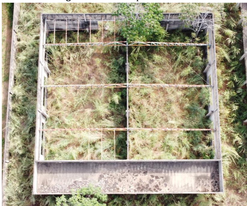
Figura 54 - Vista superior do bloco
