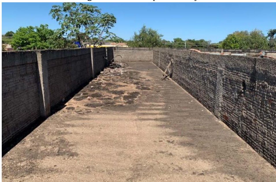
Figura 53 - Face superior da laje
