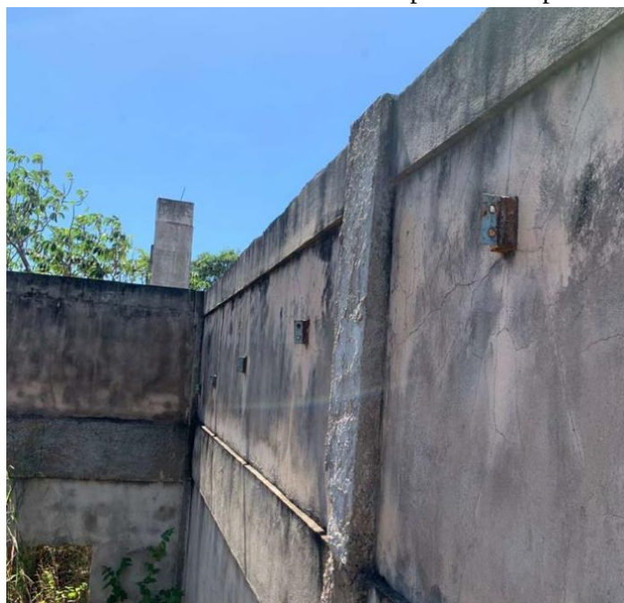
Figura 52 - Elementos da estrutura metálica apoiados no painel de alvenaria
