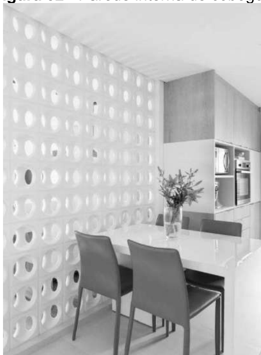
Figura 32 - Parede interna de cobogós.
