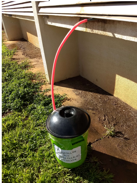
Figura 08 – Instalação do dreno para coleta de dados
