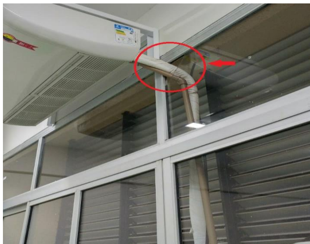
Figura 1- Tubulação frigorífera dreno e entre vidro cortado
