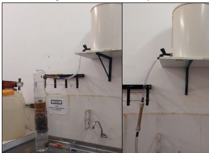
Figura 15: Sistema de filtragem
