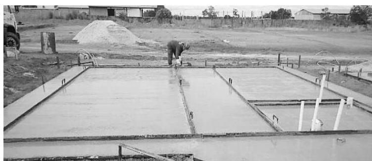
Figura 5 – Execução da Fundação tipo radier, detalhe do rebaixo do banheiro e das tubulações. Jardim Vitória, Palmas – TO
