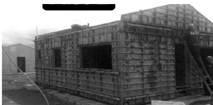
Figura 6 – Execução das paredes de concreto moldado in loco, Jardim Vitória, Palmas-TO
