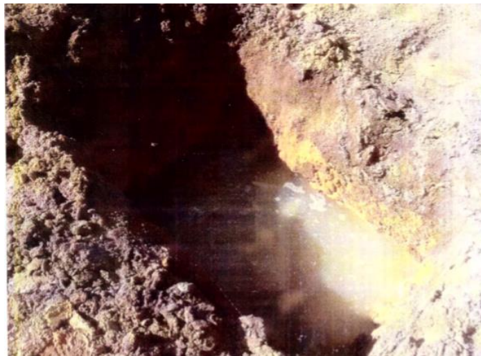
Foto 2: Escavação da fundação
