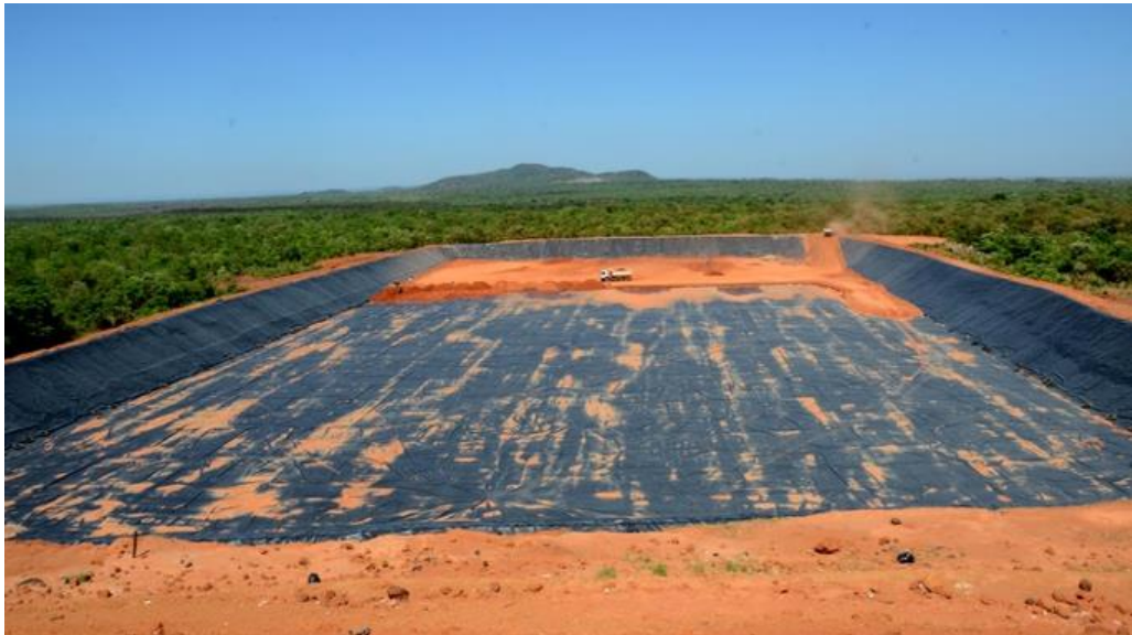
Figura 13: Vala do Aterro Sanitário de Palmas.
