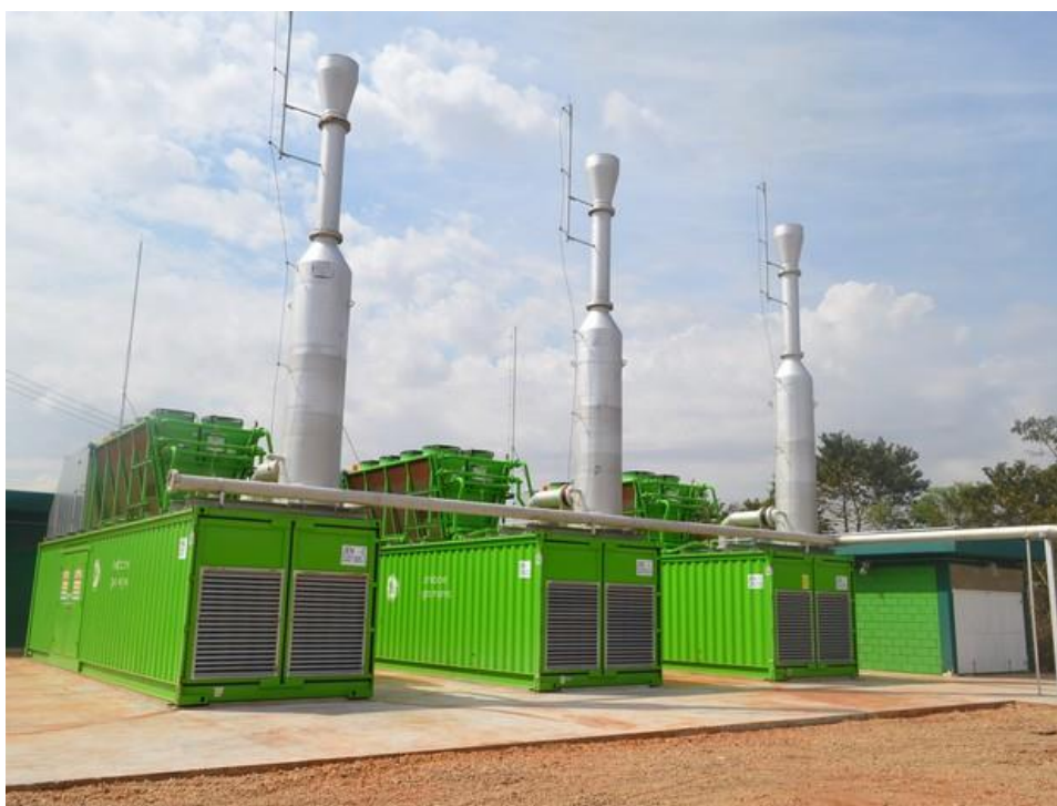
Figura 11: Motogeradores da Usina de Guatapar – SP.
