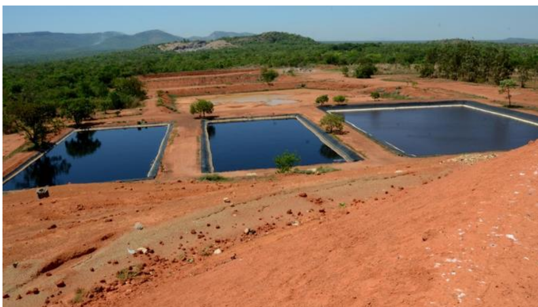
Figura 15: Sistema de lagoas para tratamento de chorume.
