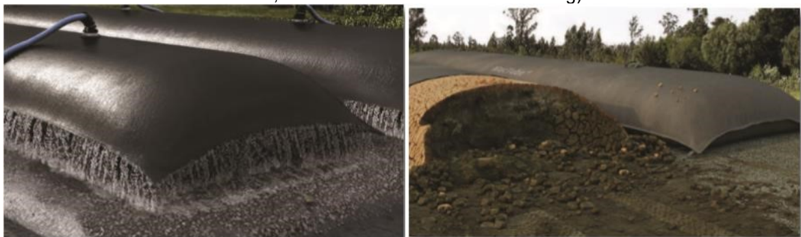
Figura 5 - Sistema de filtração em bag de geotêxtil (a esquerda, o bag durante o bombeamento; a direita, o resíduo sólido consolidado no bag)
