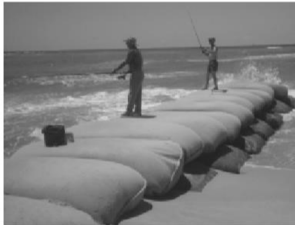
(c) sacos geotêxteis
