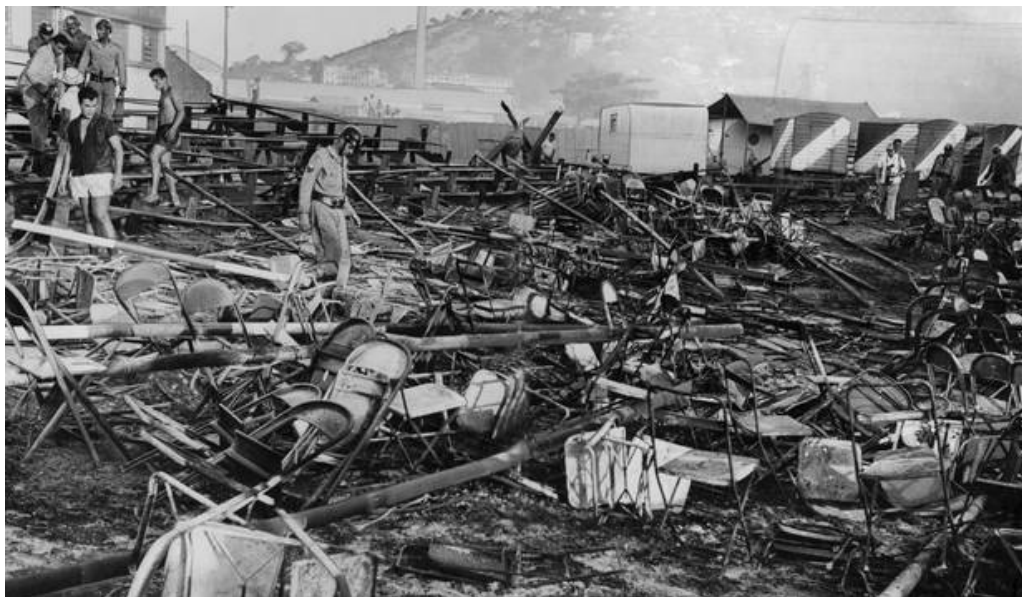
Figura 1 - Escombros após incêndio Gran Circus Norte-Americano
