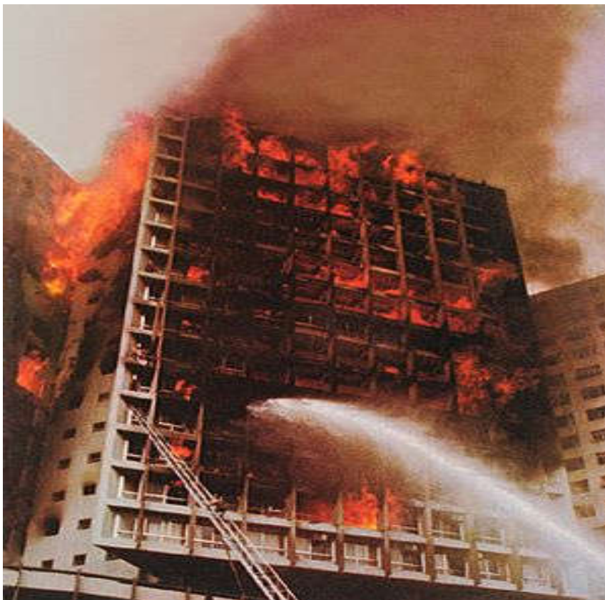
Figura 3 – Fogo no Edifício Joelma
