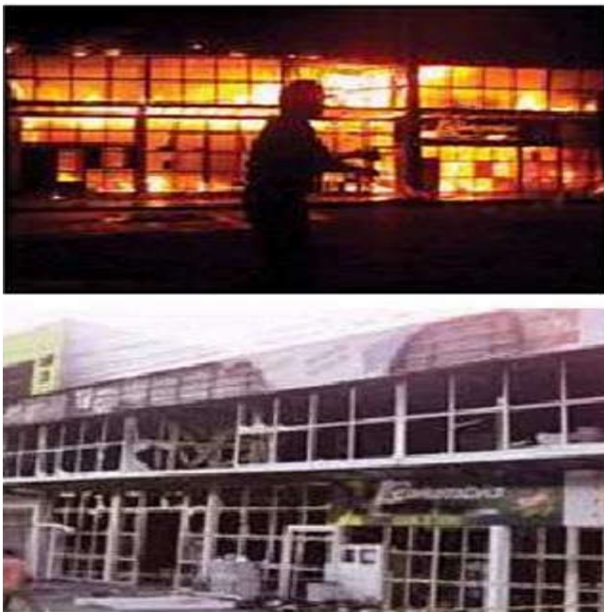
Figura 5 – Incêndio na loja Colúmbia
