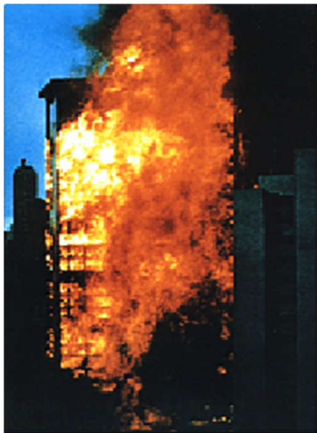
Figura 2 – Edifício Andraus em chamas
