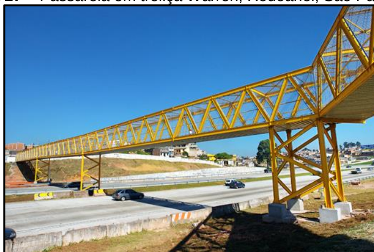
Figura 27 – Passarela em treliça Warren, Rodoanel, São Paulo - SP
