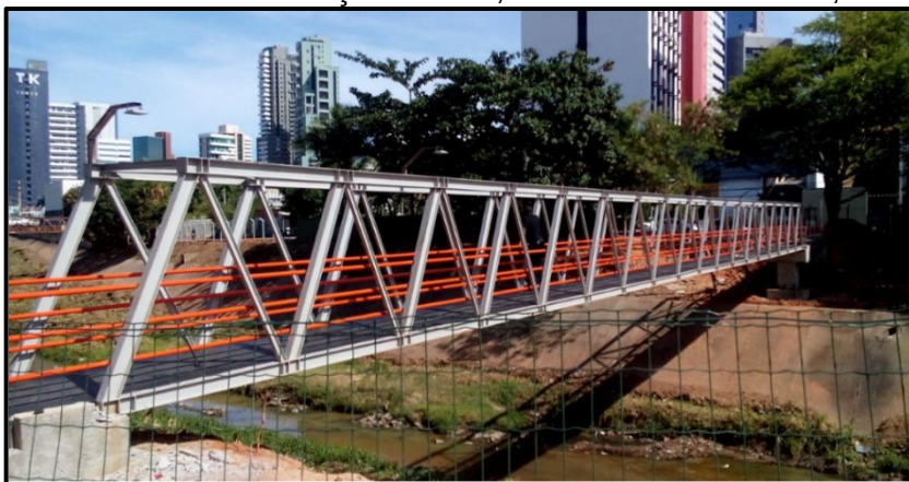
Figura 26 – Passarela em treliça Warren, Av. Tancredo Neves, Salvador - BA
