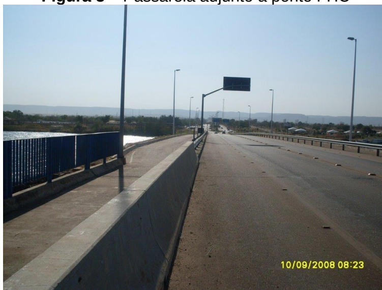
Figura 3 – Passarela adjunto a ponte FHC
