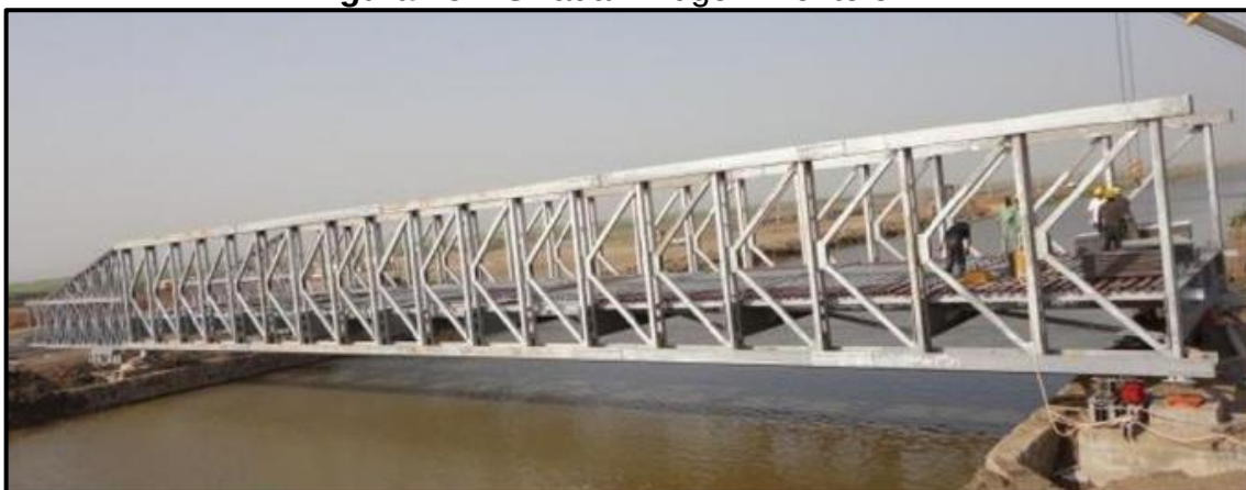
Figura 25 – Sivadal Bridge – Ponte em K
