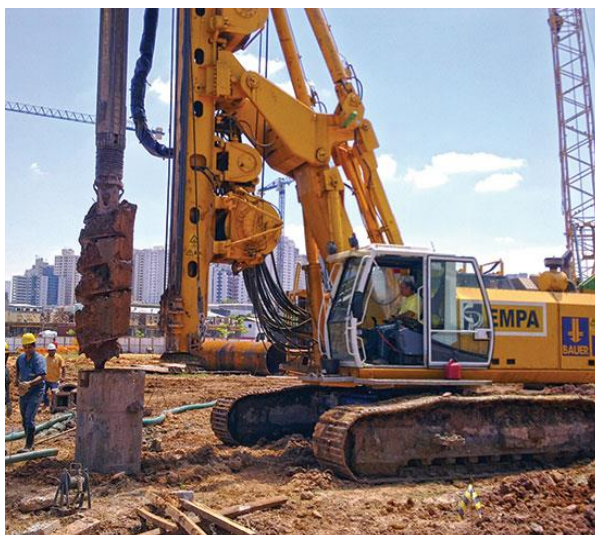
Figura 8- Estacas Escavadas.
