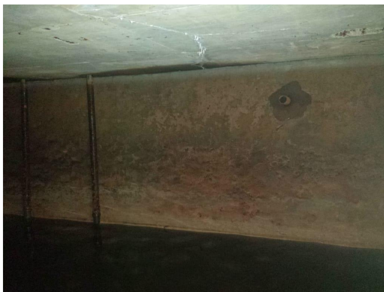
Figura 18 – Vista geral do reservatório enterrado
