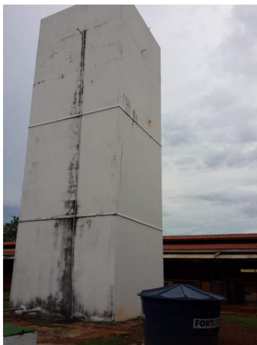
Figura 11 – Reservatório elevado em concreto armado e caixa d'água provisória de polietileno
