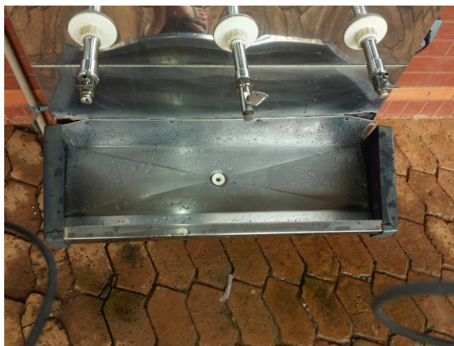
Figura 36 – Bandeja do bebedor estragada
