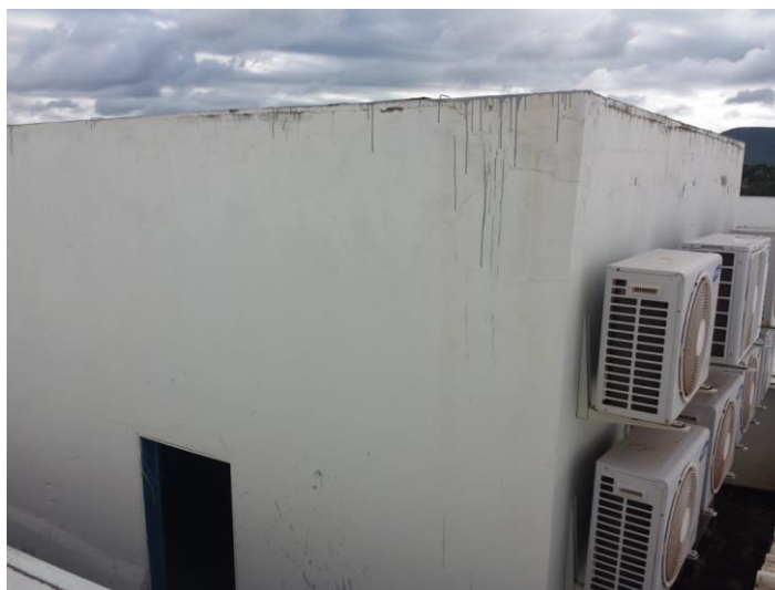
Figura 25 – Visão geral reservatório elevado biblioteca
