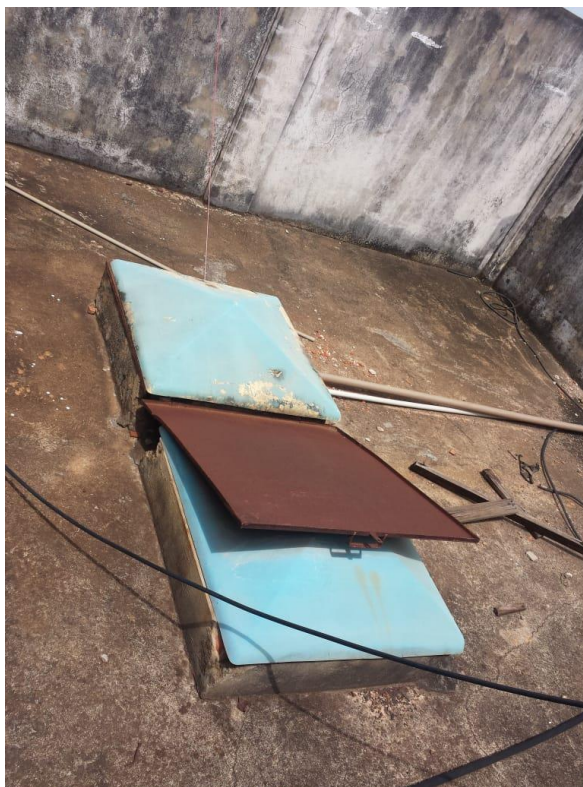
Figura 15 – Alçapões reservatório elevado, nível laje de cobertura
