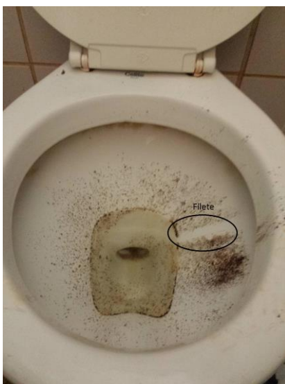
Figura 30 – Vazamento filete
