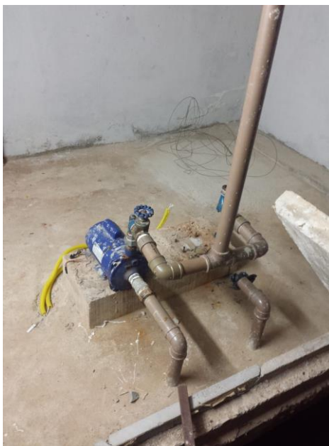
Figura 23 – Casa de máquinas reservatório enterrada biblioteca
