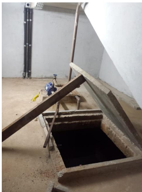
Figura 24 – Alçapão em concreto armado reservatório enterrado biblioteca
