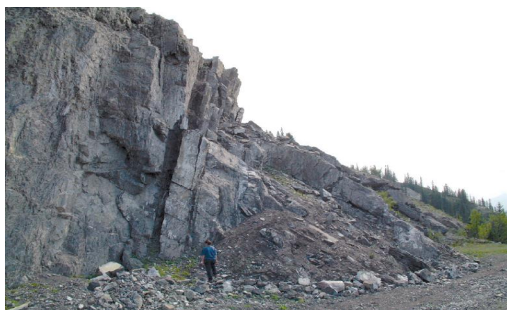
Figura 7 - Exemplo de queda de blocos.
