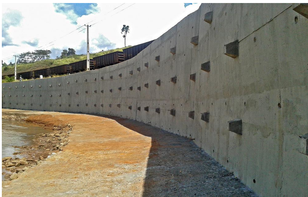
Figura 19 - Cortinas atirantadas.
