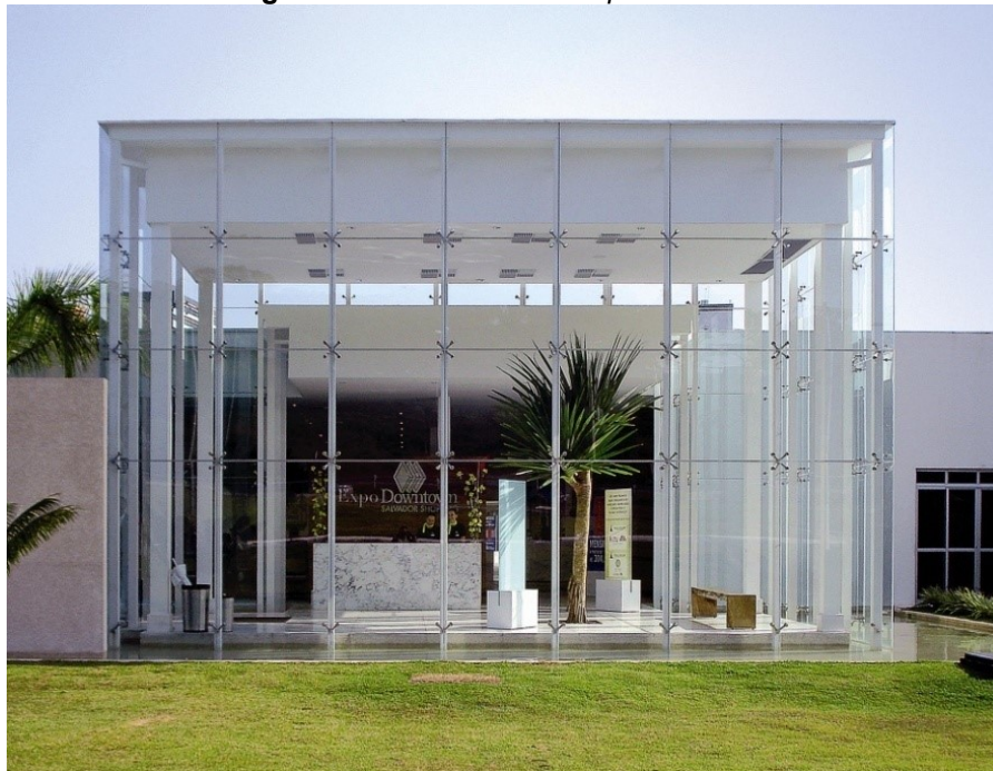
Figura 22 - RNA de vidro " Spider Glass "
