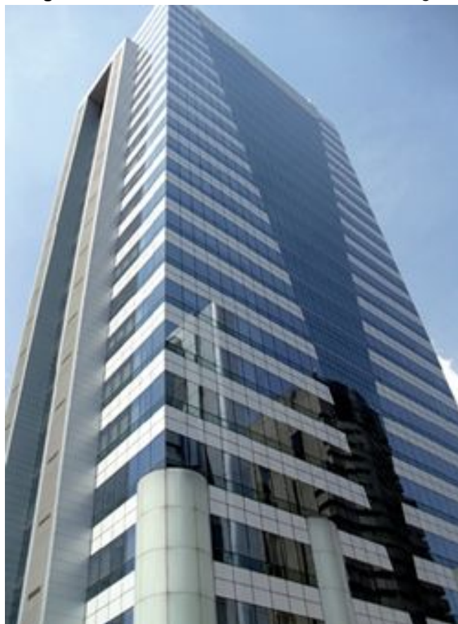
Figura 21 - Fachada de vidro " Structural Glazing "
