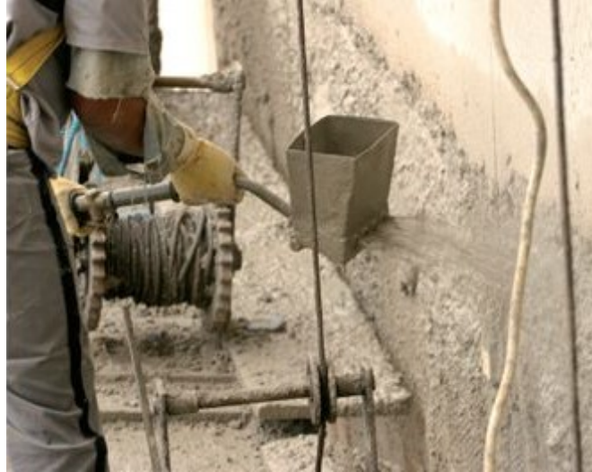
Figura 9 - Aplicação projetada do revestimento monocapa
