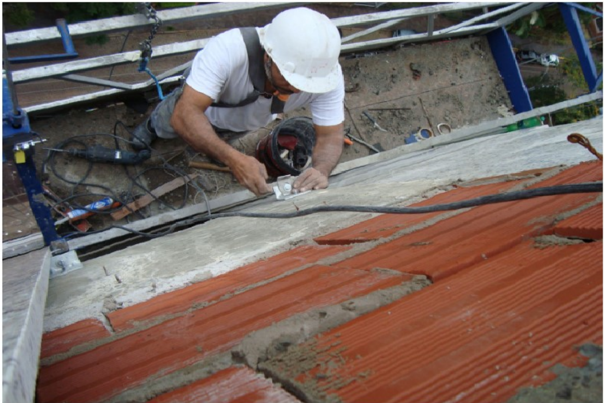
Figura 19 - Execução do RNA em placa pétrea
