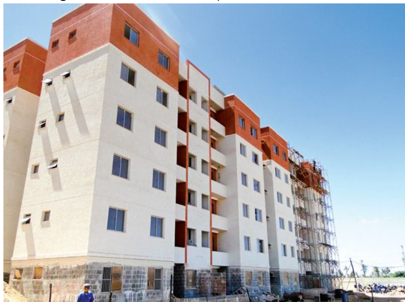
Figura 10 - Fachada monocapa em edifício residencial
