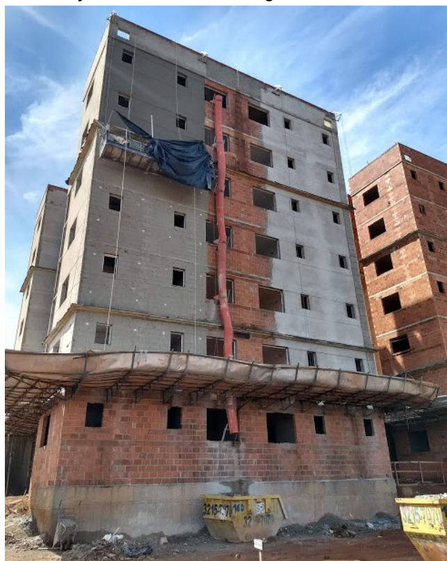
Figura 2 - Execução do revestimento argamassado de base cimentícia
