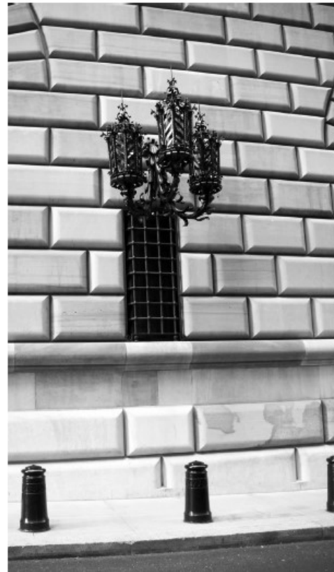
(b) Fachada revestida com arenito.
