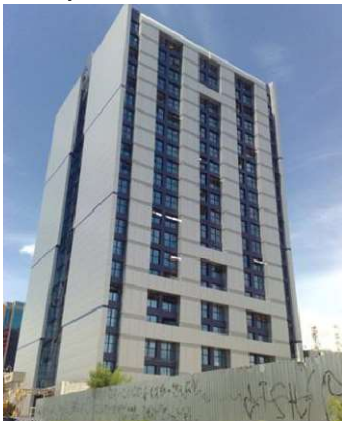
Figura 13 - Fachada com RNA em ACM
