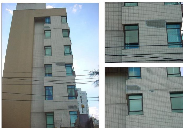
Figura 5 - Fachada de edifício com revestimento em placas cerâmicas
