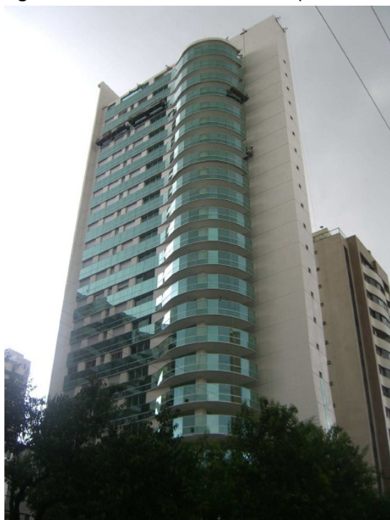
Figura 16 - Fachada com RNA em porcelanato
