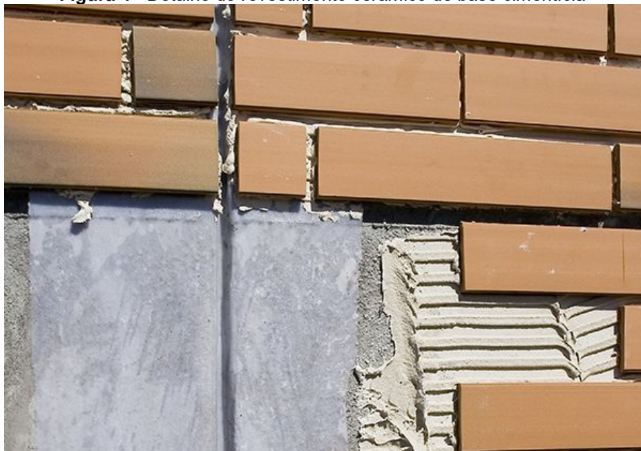
Figura 4 - Detalhe do revestimento cerâmico de base cimentícia
