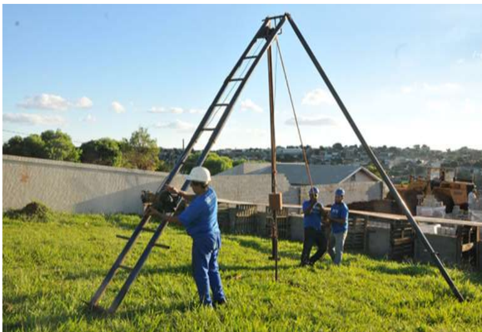
Figura 2 - Equipamentos do Ensaio SPT
