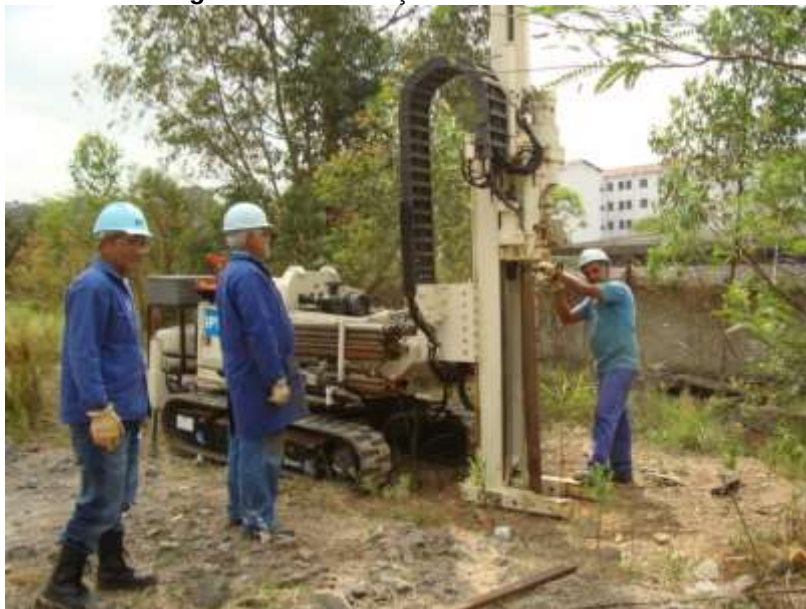
Figura 3 - Execução do ensaio CPT
