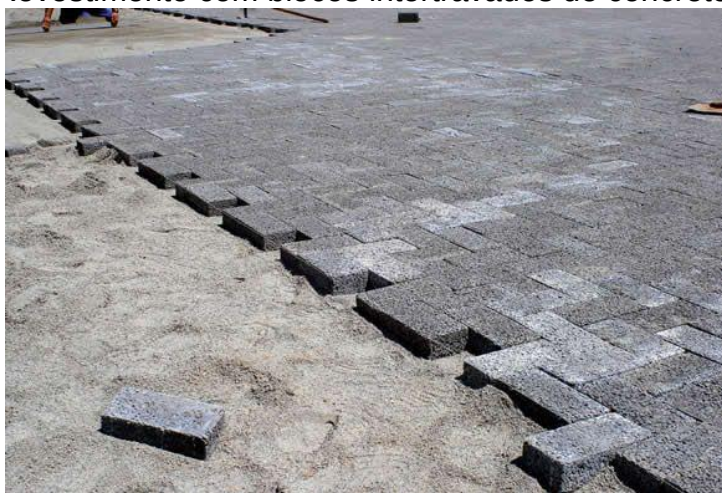
Figura 4 - Revestimento com blocos intertravados de concreto permeável.
