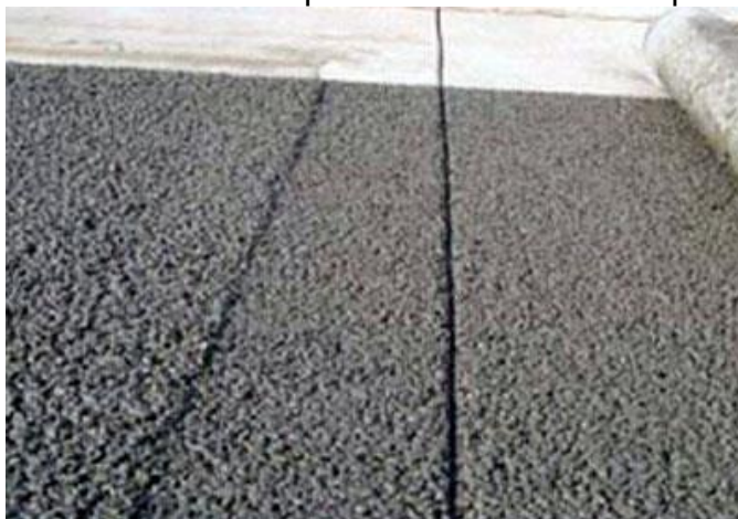
Figura 2. Textura de um pavimento de concreto permeável.
